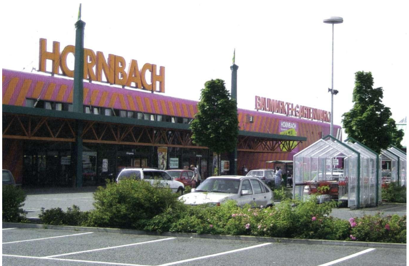
Bau- und Heimwerkermarkt in der Ebendorfer Chaussee
