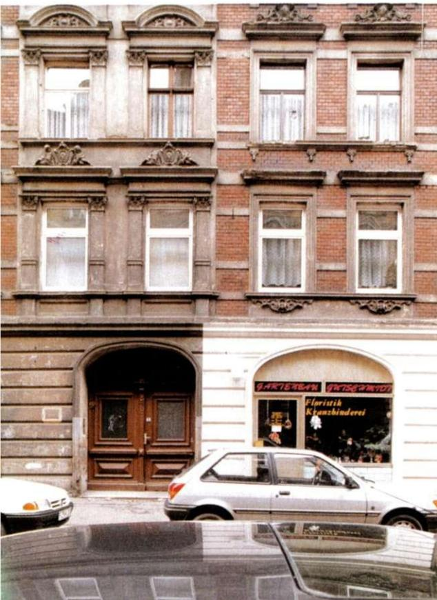
*Diese Beispiele zeigen die Notwendigkeit des Einbaus von gegliederten Stulpfenstern in die historischen Fassaden. Andere Fenster werden nicht genehmigt. Sie müssen bei der Fassadensanierung durch stilgerechte Fenster ersetzt werden.*
