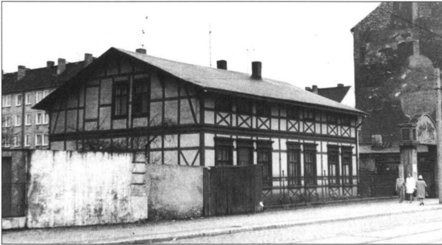
Abb. 18 b Alte Neustadt, Agnetenstraße 11, Zustand 1974
