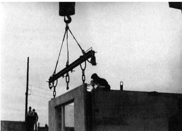
Abb.: Montage der Naßzellen der WBS 70
