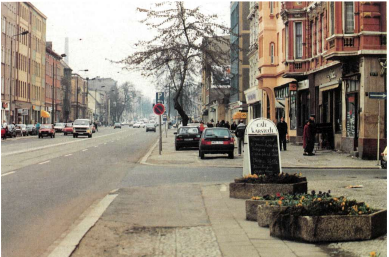
Halberstädter Str. vor dem Umbau
