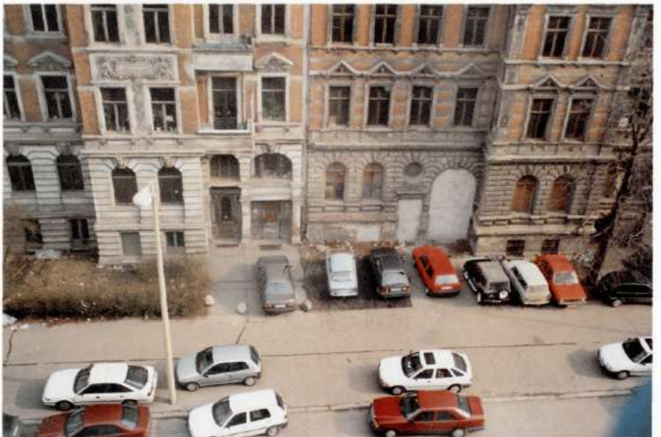
Schieinufer 13 und 14 wertvolle alte Fassaden werden erhalten, ein Experiment als Ausnahme
