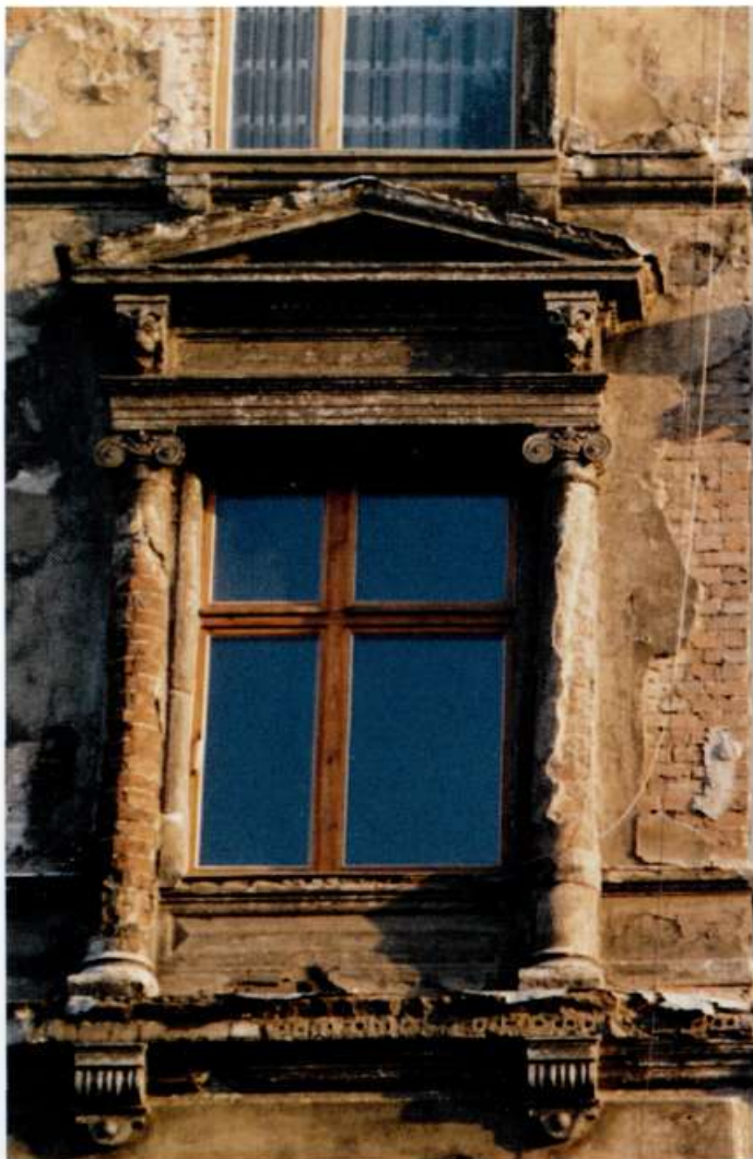
Leibnizstraße 49 (links) Zustand vor der Sanierung
