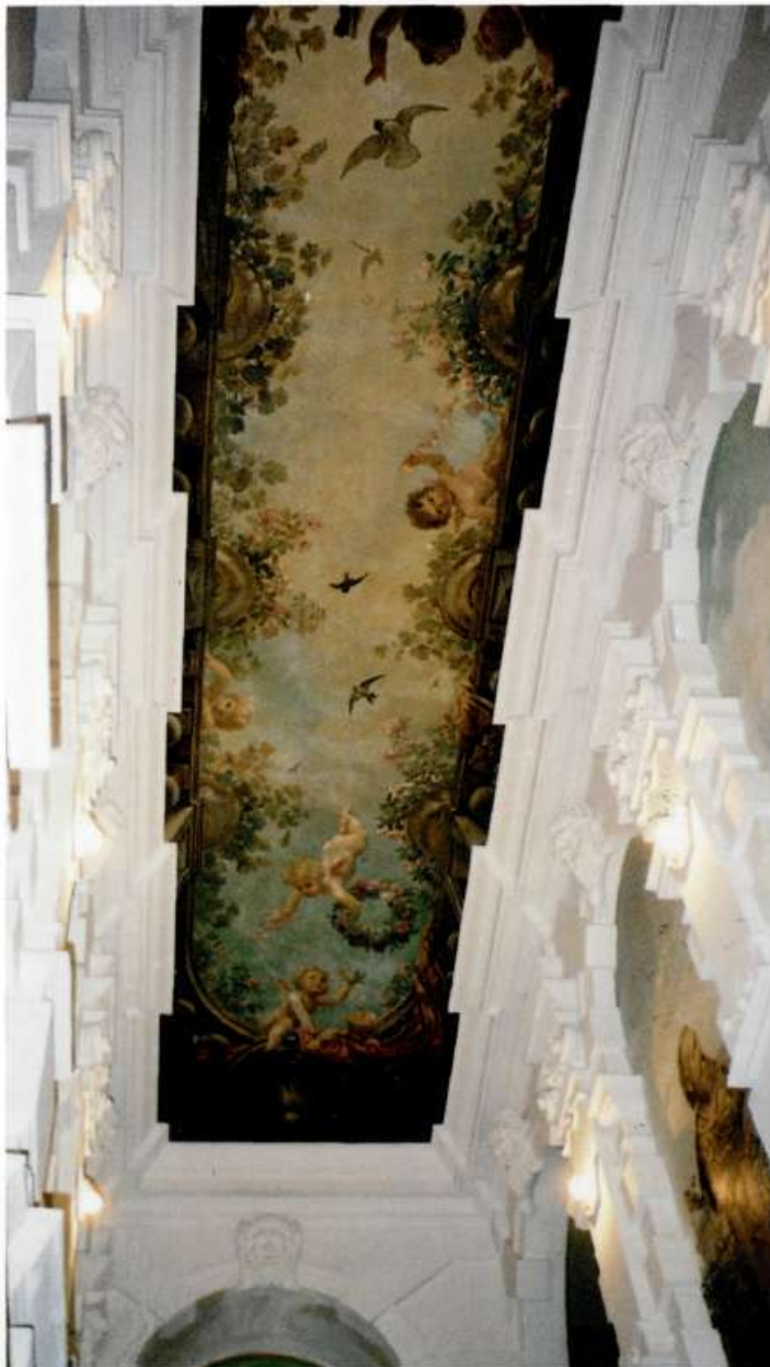
Hegelstraße 16 Rekonstruktion historischer Wandmalerei 1992
