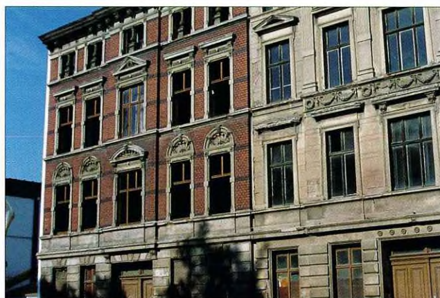
Impressionen aus dem Aktionsfeld - Grundstücke, die nicht oder nur teilweise genutzt sind, mit zahlreichen brachliegenden gewerblichen Bauten, sowie einzelne Wohnhäuser, die leer stehen. Hier: (oben) Grundstück an der Schwiesaustraße, (mittig) Grundstück an der Nachtweide, überwiegend versiegelt und von Gleisen durchzogen, (unten) Wasserkunststraße 21 und 22, denkmalgeschützt
