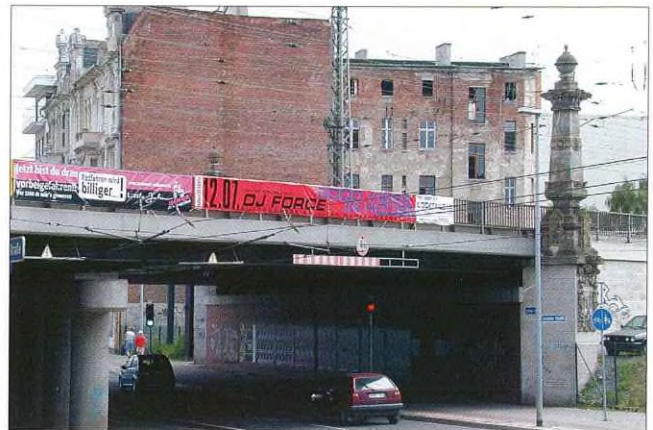
Eisenbahnbrücke am Stadtteilübergang von der Alten zur Neuen Neustadt, Ist-Zustand
