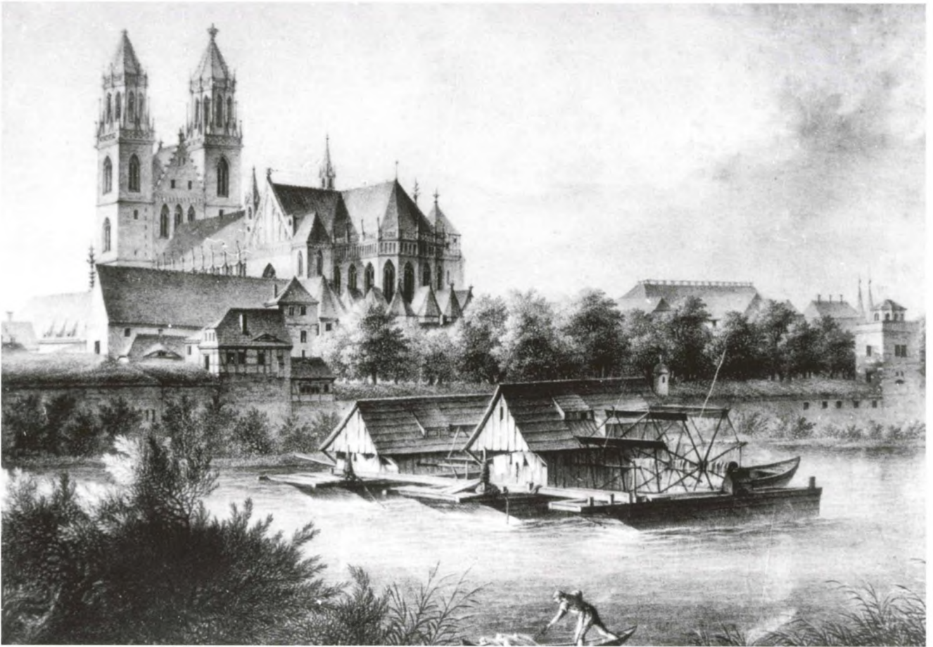
Schiffsmühle auf der Elbe vor dem Magdeburger Dom, das Bild zeigt eine Sonderform der Schiffsmühlen mit zwei Hausschiffen, einem Wellschiff und zwei Schaufelrädern 1825, Lithografie von Schmidt nach einer Zeichnung von Köhler
