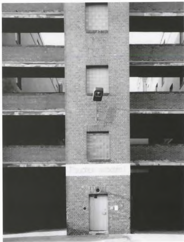
Industriemühle am Klosterkamp, Detail zwischen Mühle und Speicher
