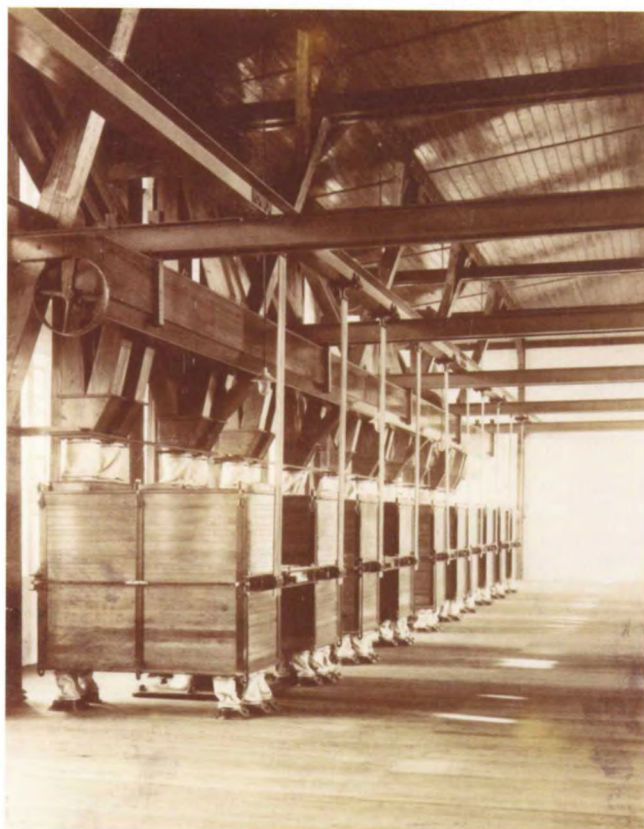
Magdeburger Mühlenwerke, Schartaustraße 1 – 3, Plansichterboden, Aufnahmen von 1912, Zustand bis 1930
