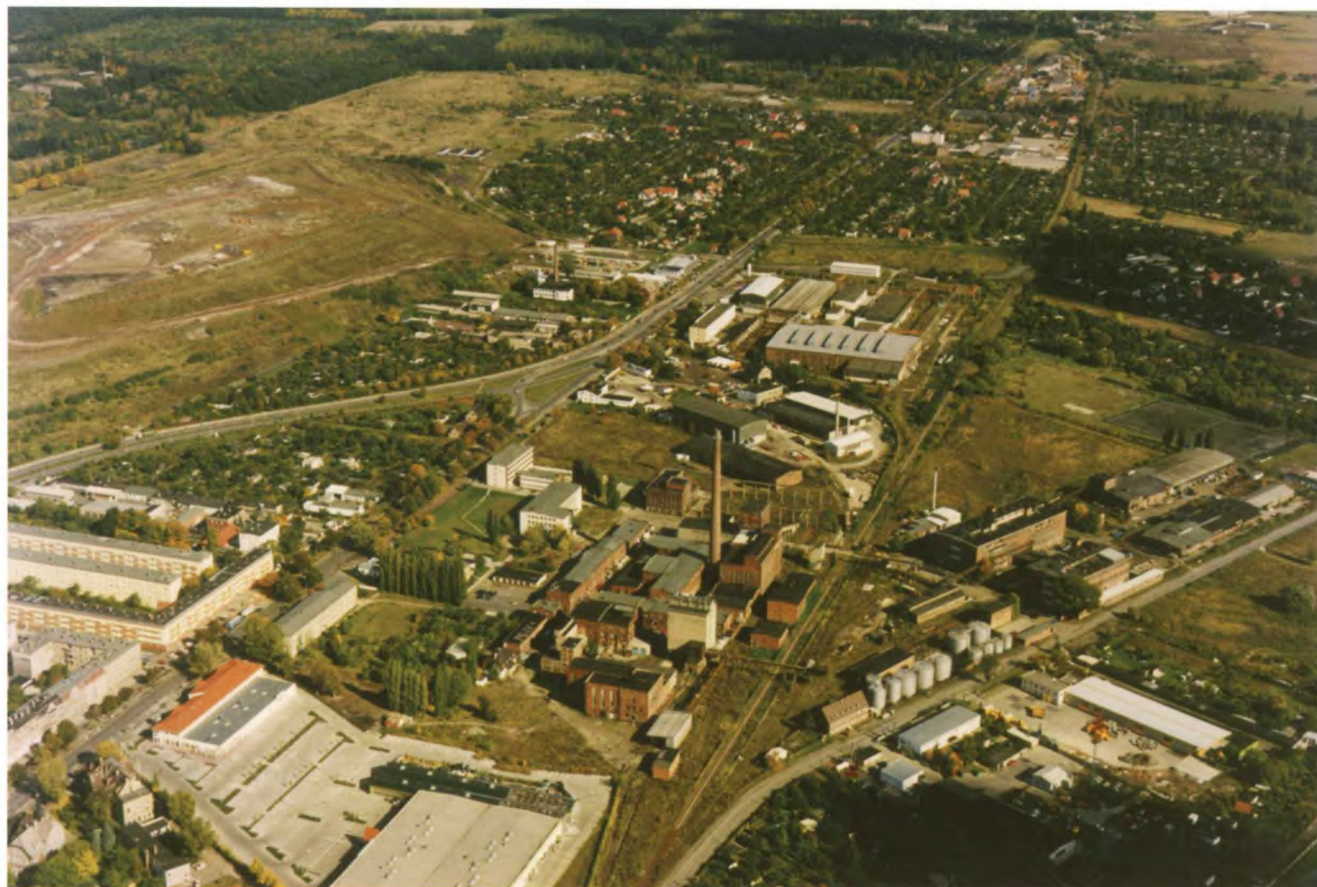
Luftbild des Geländes der früheren Vereinigten Ölfabriken Hubbe und Farenholtz in der Berliner Chaussee 66, Zustand vor den umfangreichen Abrissmaßnahmen
