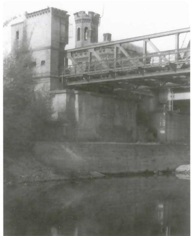
Alte und neue Herrenkrug-Eisenbahnbrücke auf einem Foto vom 7. Juni 1988; der die Schiffe behindernde Pfeiler in der Hafeneinfahrt ist noch vorhanden und wird erst mit der Demontage der alten Brücke beseitigt (HGe)
