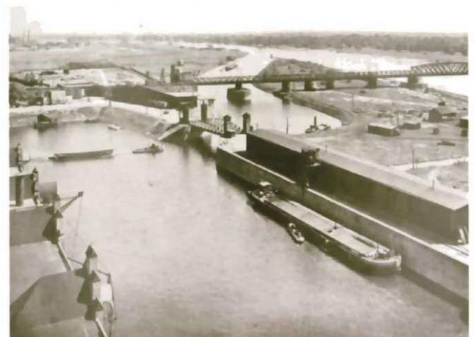
rampen der Platz fehlte, ließ sich die Errichtung einer beweglichen Brücke nicht vermeiden. Von den in Betracht kommenden Systemen entschied man sich für eine hydraulisch betriebene Hubbrücke. Unter der Projektleitung der im Maschinenbau versierten Firma C. Hoppe, Berlin, entstand 1893 eine der ersten Hubbrücken Deutschlands.
