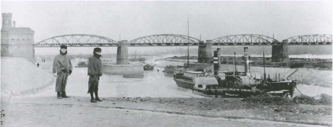
*Herrenkrug-Eisenbahnbrücke mit Einfahrt zum Handelshafen; der große Pfeiler in der Hafeneinfahrt behinderte über hundert Jahre lang die Schifffahrt erheblich, bis er nach 1988 mit dem Neubau der Brücke entfernt wurde (StAM)*
