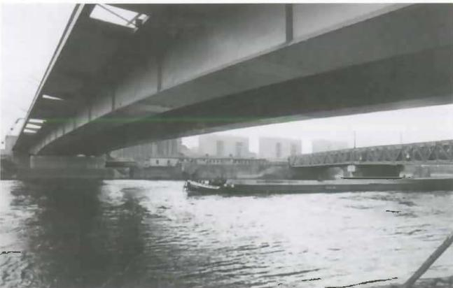
Am 24. Juli 1964 begann das Einschleppen der Brücke frei über den Strom. Der Einschleppvorgang auf der Ostseite der Elbe dauerte vom 13. bis 23. August 1964. Das Verlegen der Fahr- und Gehbahnen sowie der Straßenbahngleise und Rohrleitungen, die Montage der Geländer, der elektrischen Anlagen sowie der Steinmetzarbeiten und Anstriche besorgte das Wohnungsbaukombinat Magdeburg.
