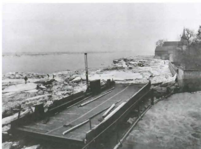
Es wurde die heute noch benutzte „fliegende“ oder Gierseilfähre entwickelt. Die Fähre ist an einem in Strömungsrichtung in der Elbe liegenden Pendelseil befestigt. Dieses 100 bis 200 Meter lange Seil ist entweder im Fluss außerhalb der Fahrrinne oder am Ufer fest verankert. Vor der Fähre spaltet es sich in zwei Führungsseile auf, die an zwei Winden auf der Fähre
