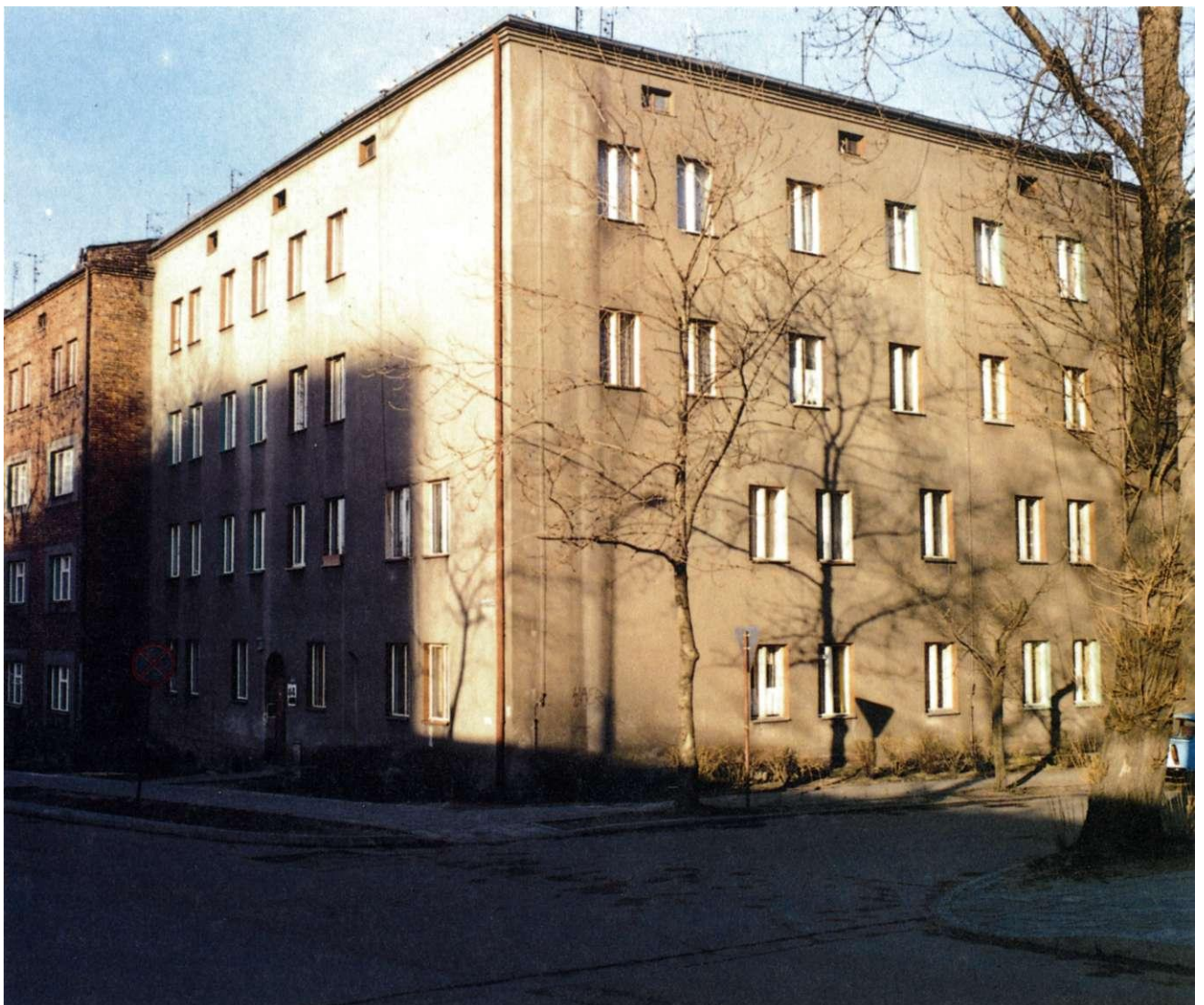
Abb. 2: Ul. Barbary, Ecke Ul. Skalna. 3. Bauteil (links) und südlicher Querbau von Bruno Taut, 1916-19. 1949-50 aufgestockt; damals vermutlich auch neue Fenster. Foto Starek
