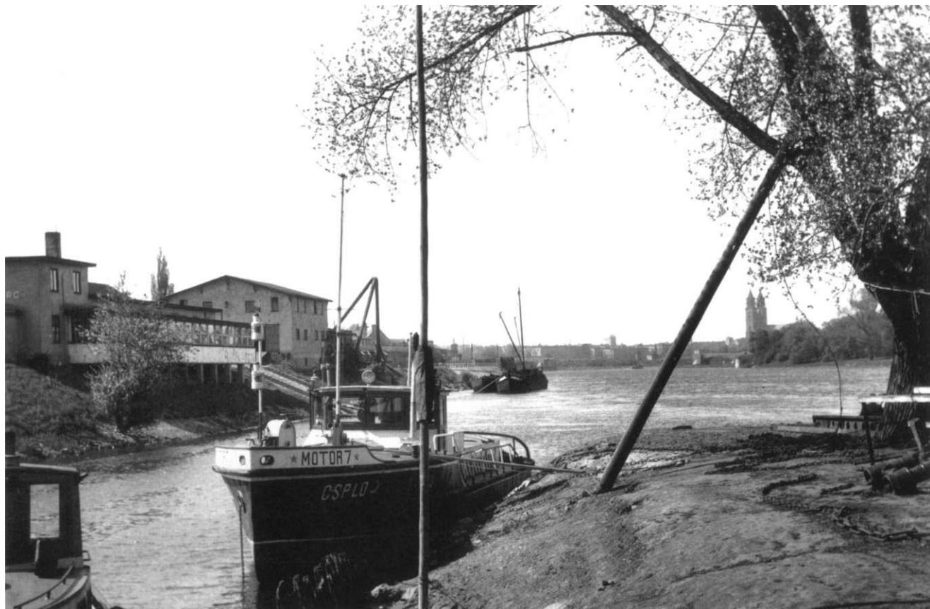
Einmündung Sülzehafen, links Rudervereinsgebäude mit Fichteheim
