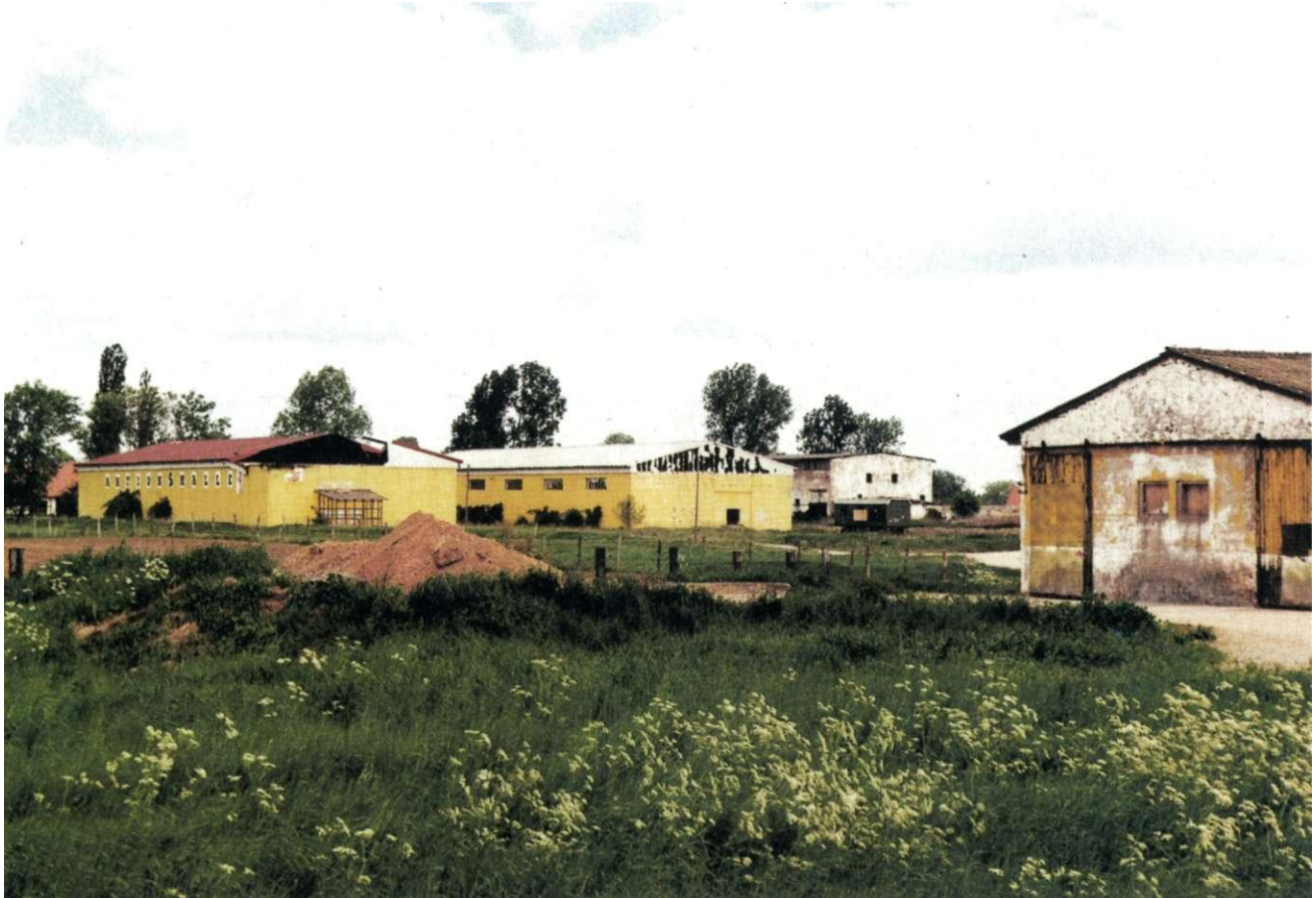
Wirtschaftsgebäude der ehemaligen LPG
