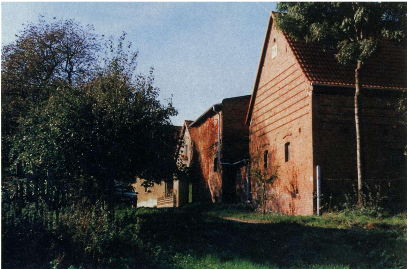
▼ Abb. 48: Stallgebäude und Scheune einer erhaltenen Hofanlage
