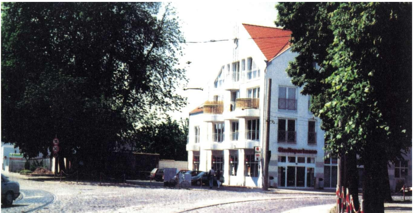
Abb. 78: Verbesserte Ortseingangssituation durch Neubebauung am Diesdorfer Knoten
