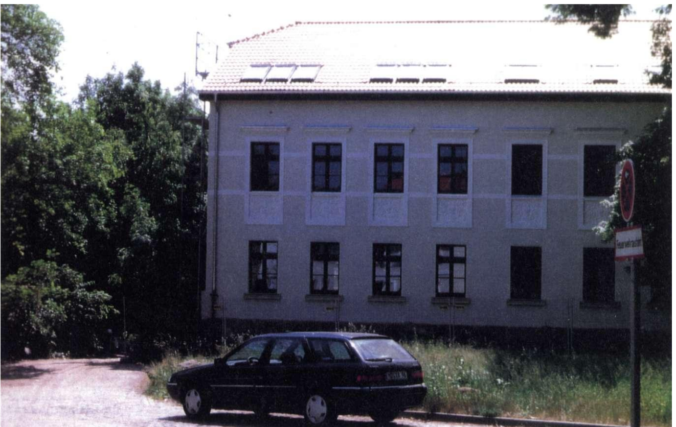
Abb. 83: Renovierte Bauernvilla am Diesdorfer Anger
