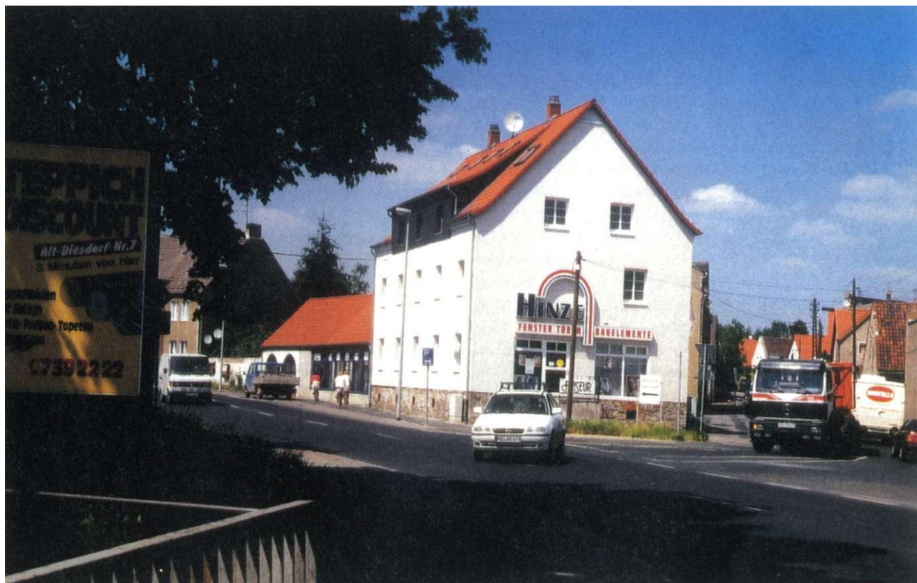
Abb. 89: Innenausbaubetrieb in modernisierter Bausubstanz Ecke Hannoversche Straße
