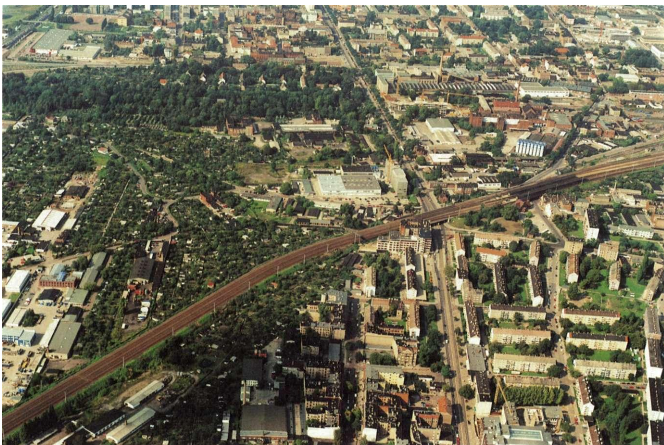
Abb. 38b: Schrägluftbild Alte und Neue Neustadt (nach Norden)
