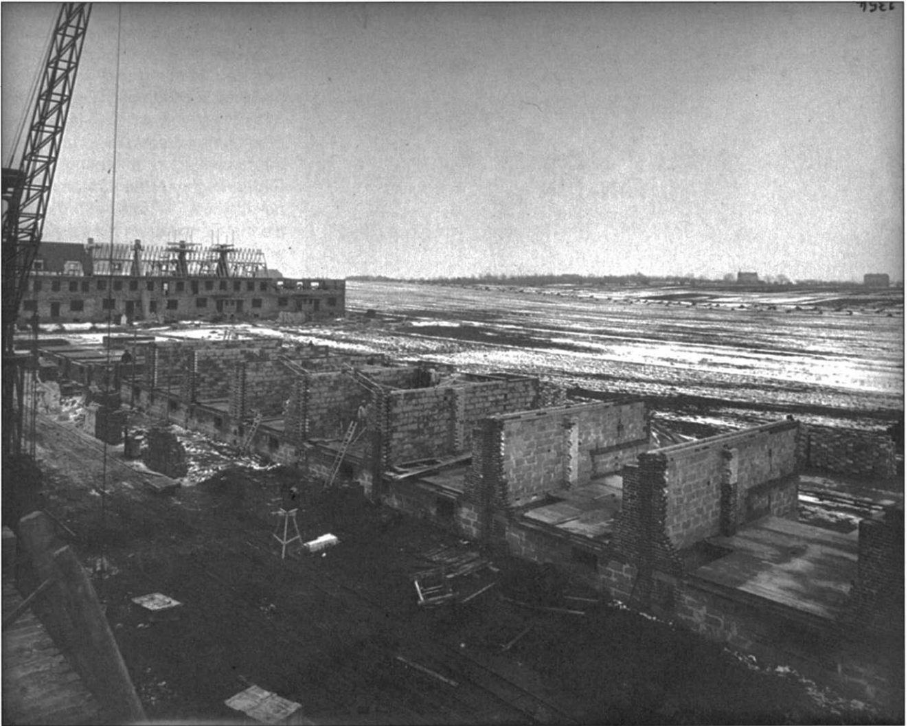
59 Baustelle Jenaer Straße 1926
