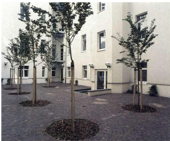
Blick in den Innenhof vor und nach der Sanierung
