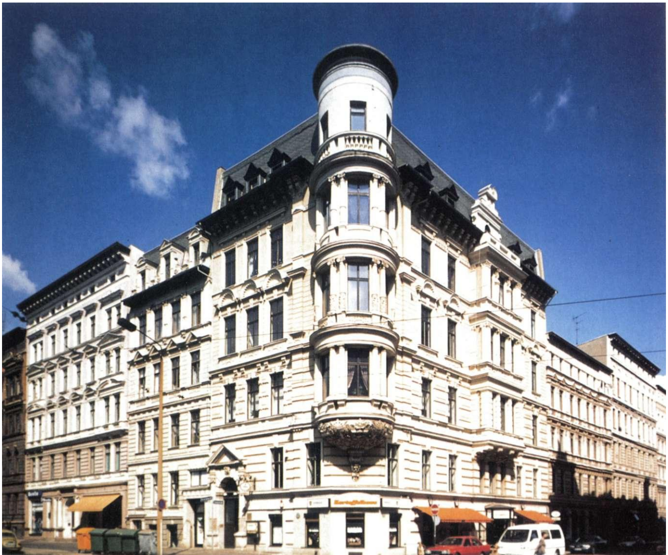
Baudenkmal Otto-von-Guericke-Straße 57 gebaut um 1882 renoviert 1988/89 Bauherr: KWV Magdeburg Ausführung: Kombinat für Baureparaturen (KBM) Magdeburg Wohnhaus mit 8 Wohnungen, Gaststätte im Erdgeschoß
