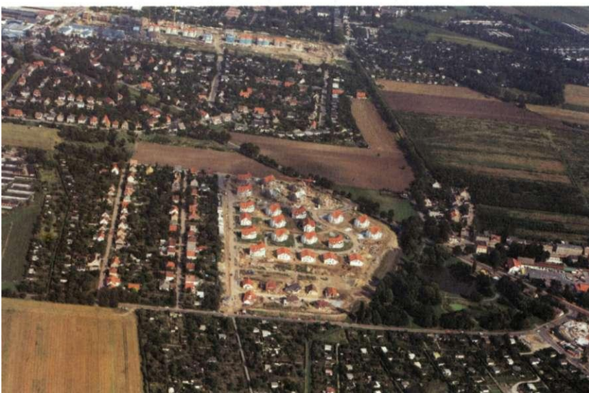
Wohngebiet „Goethe Park“ aus der Luft von Westen
