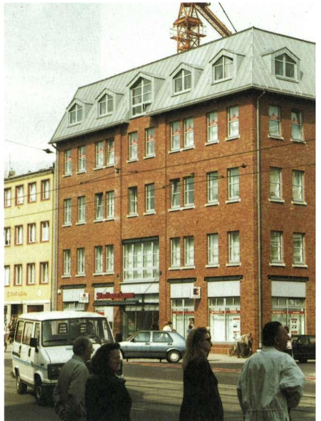
Neubau Sparkasse, Halberstädter Straße
