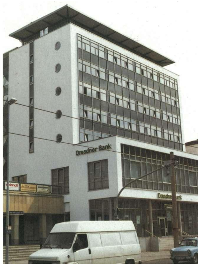
Umbau Plattenbau zum Verwaltungsgebäude "Dresdner Bank", Otto-von-Guericke-Straße/ Leiterstraße
