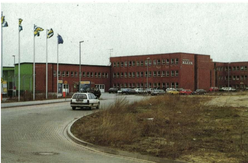
Verwaltungsgebäude im Gewerbegebiet südlich Salbker Chaussee
