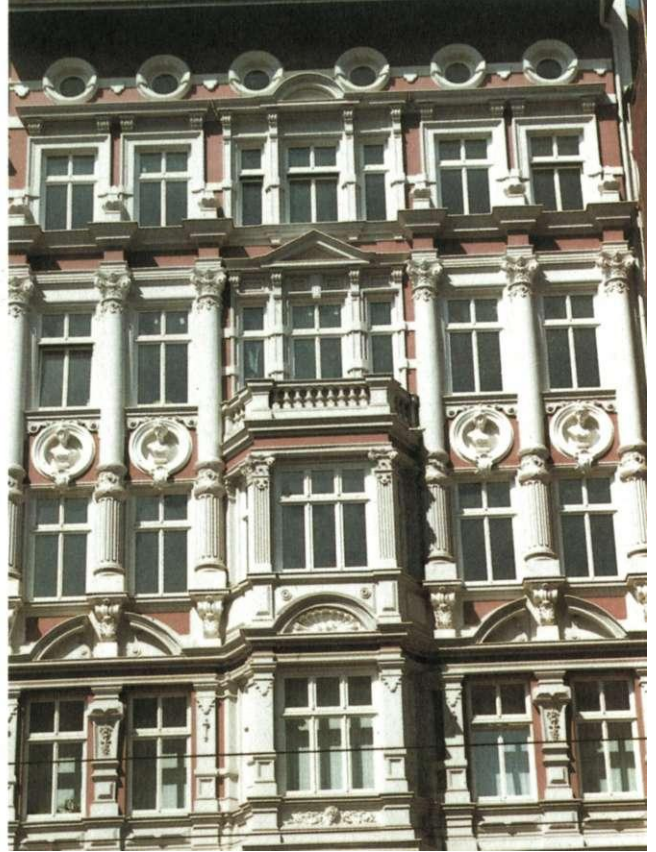
Rekonstruktion Geschäftshaus, Otto-von-Guericke-Straße 49a
