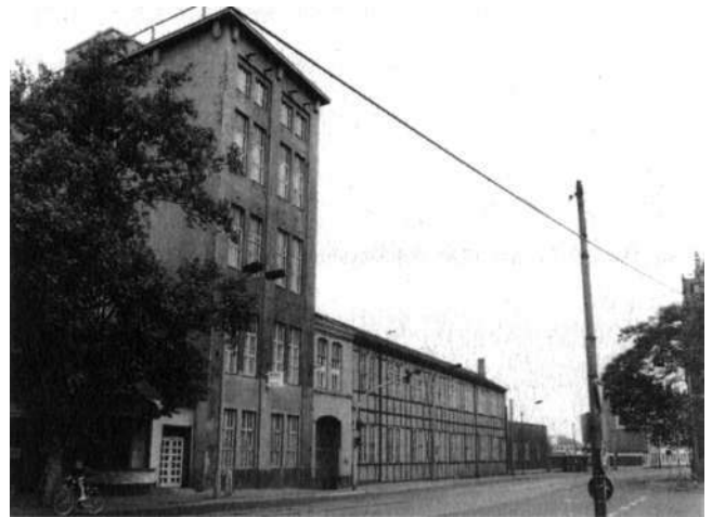
Schönebecker Straße, Bauten der Firma Messma
