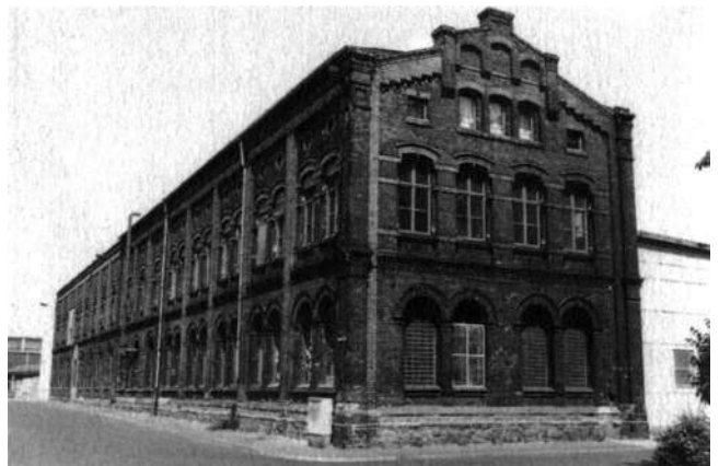
Produktionsgebäude Gnadauer Straße/Ecke Weststraße
