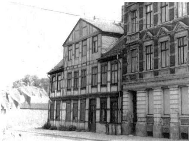
Bebauung in der Fährstraße
