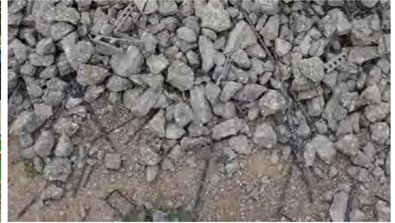
Abb. 1 bis Abb. 3: Abbruch von Bauwerken aus Carbonbeton
