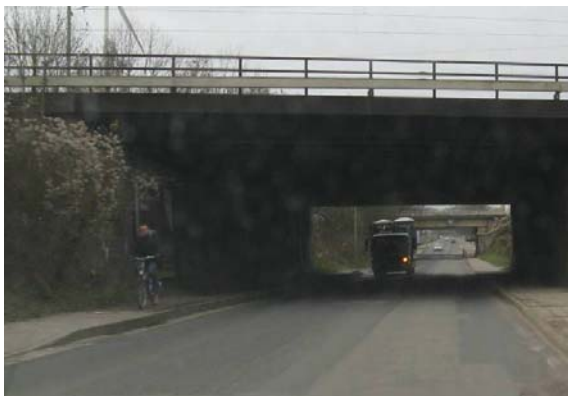
fehlende Radverkehrsanlagen Schanzenweg
