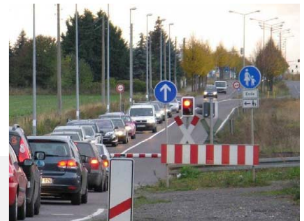
fehlende Radverkehrsanlagen Ottersleber Chaussee
