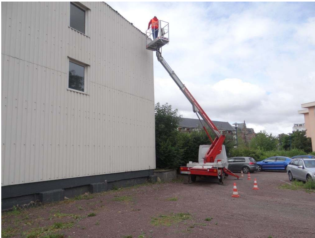
Abbildung 16: Untersuchung der Dachüberstände und Randabschlüsse auf Fledermäuse oder deren Nachweise
