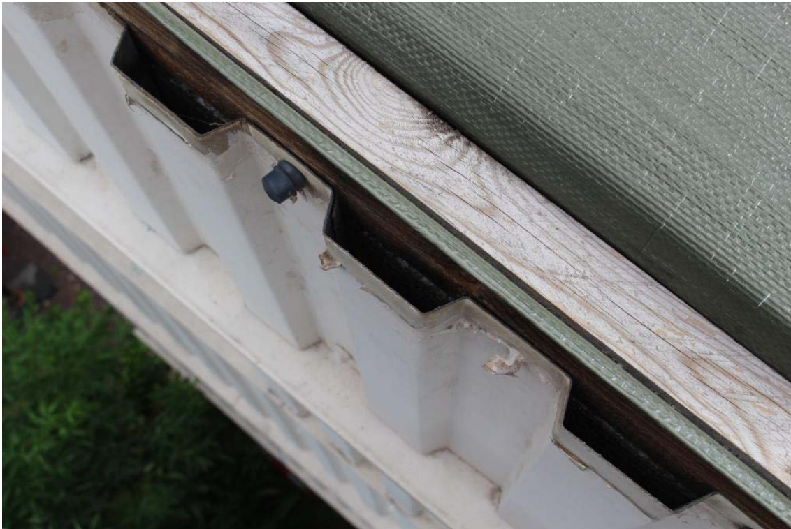
Abbildung 17: vorgehängte Fassade an dem Verwaltungsgebäude
