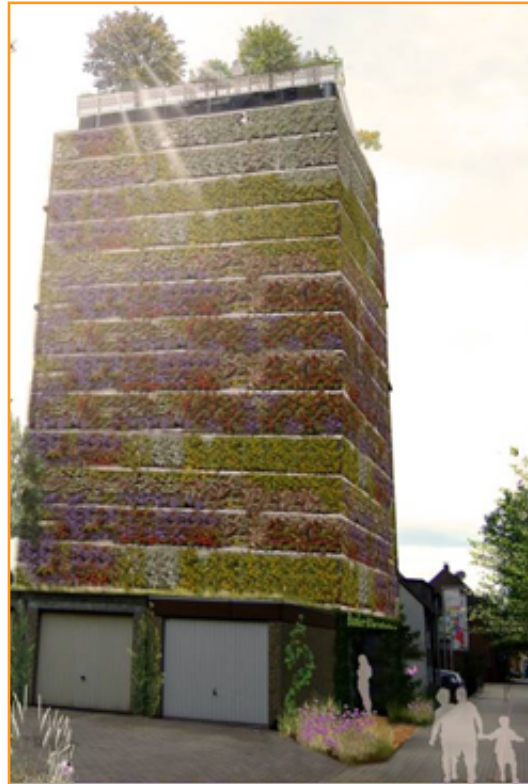
Abb. 9: Hochbunker mit Begrünung und Aussichtsplattform
