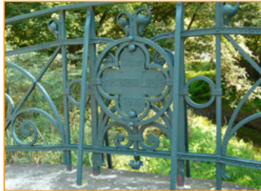
Abb. 1: Stifterplakette an der Laaßbrücke im Stadtpark Rotehorn.
