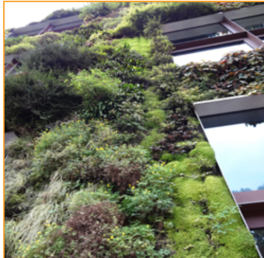
Abb. 6: Vertikaler Kühlraum, Paris Quelle: bgmr Landschaftsarchitekten
