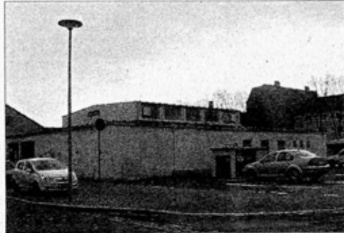
Die ehemalige Kaufhalle in der Weinbergstraße ist mittlerweile abgerissen. Die MWG plant hier eine Bebauung, voraussichtlich 2011.
