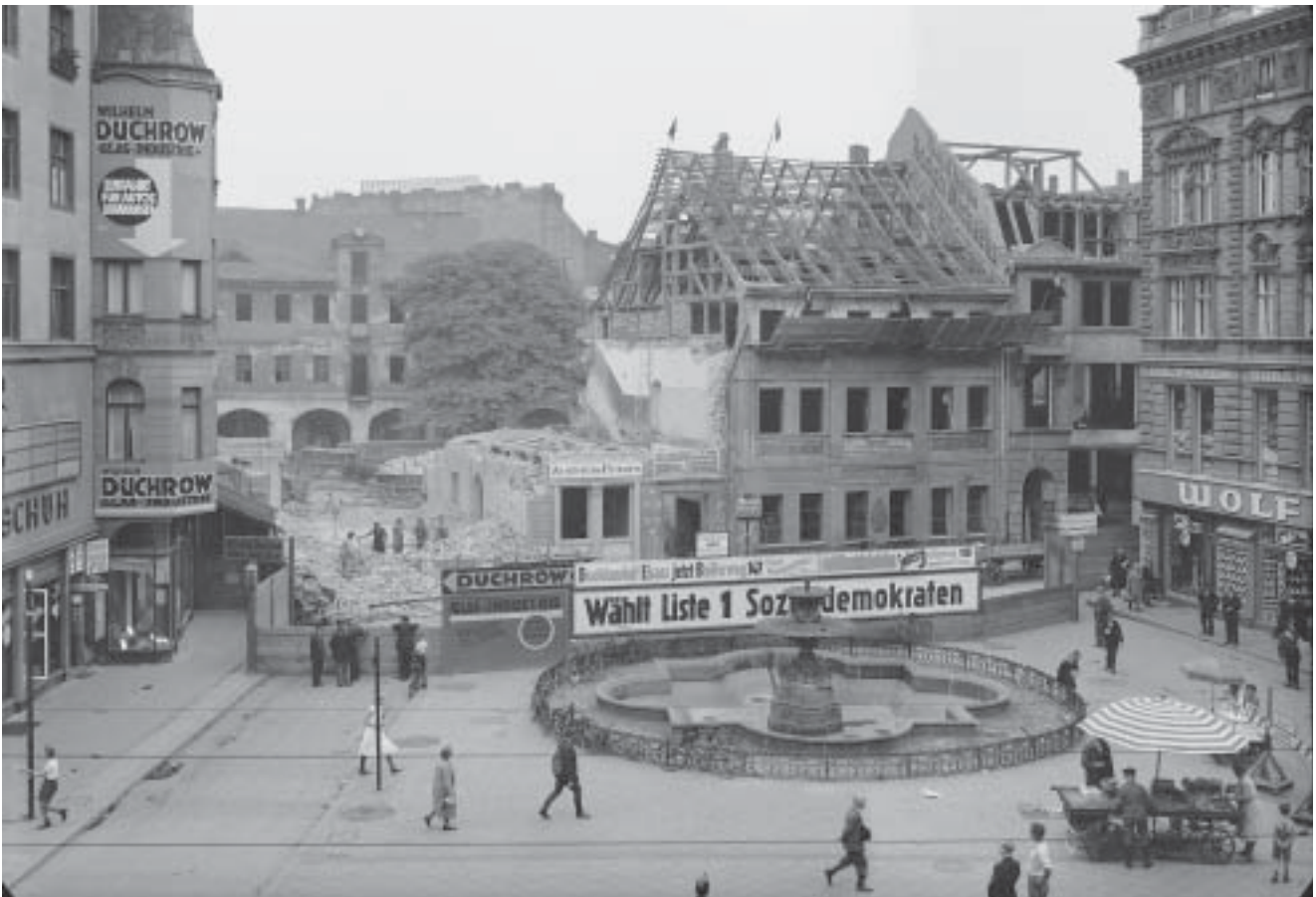
Abbruch der alten Gebäude am Ratswaageplatz, 1932
