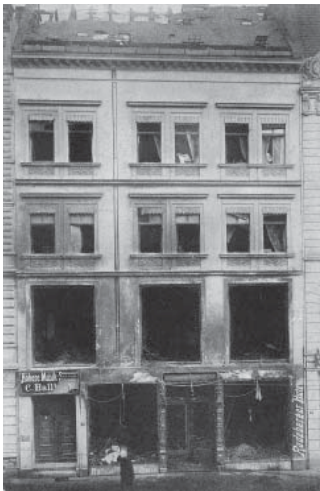
Das ausgebrannte Haus Breiter Weg 65, 1907
