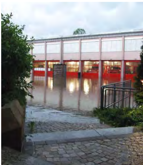
Abbildung 23: Auch Einrichtungen der Gefahrenabwehr waren von den Auswirkungen starker Niederschläge im Odenwald betroffen (Feuerwache Buchen, 30.5.2010)
