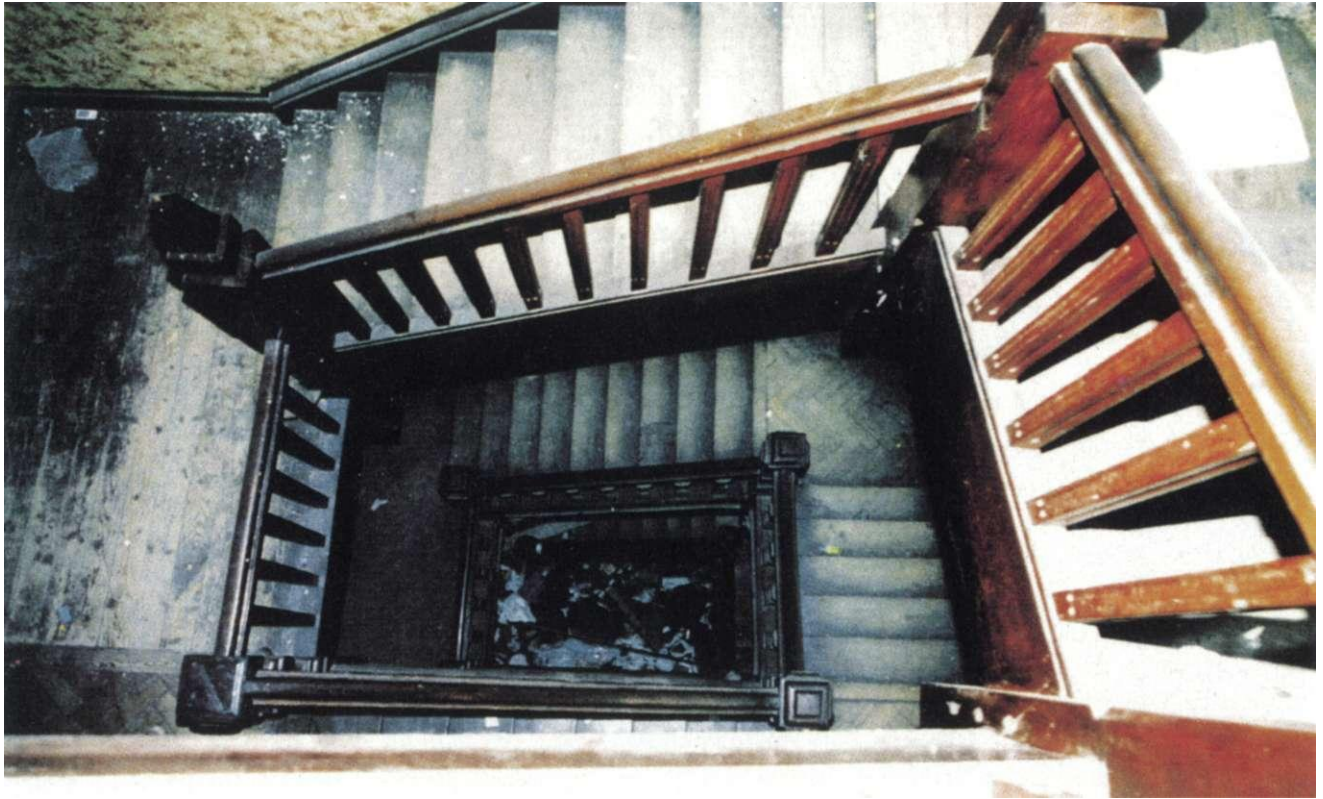
Abb. 81 Hegelstraße 31 Rechtwinklig geführtes Treppenhaus, 1888
