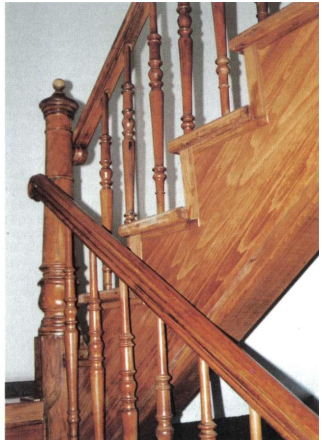
Abb. 87 Heydeckstraße 9 Schmale Geländertraillen und schlichte Pfosten in einem Gebäude aus dem Jahr 1879
