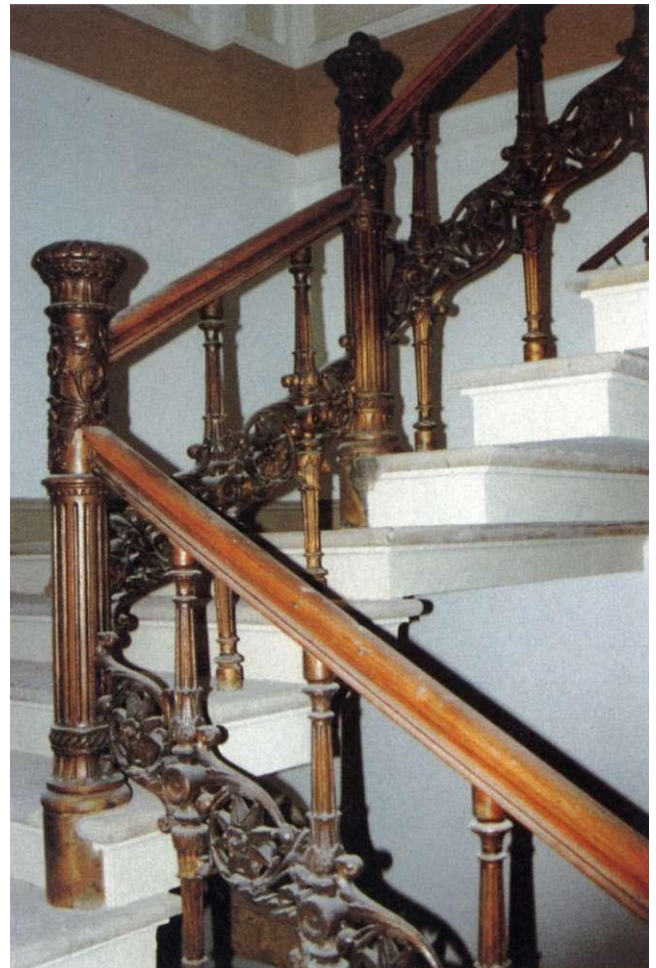
Abb. 83 Hegelstraße 1 Treppengeländer aus Gußeisen, 1878
