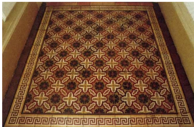
Abb. 110 Hegelstraße 15 Diagonal verlaufendes Fußbodenmuster aus glatten Fliesen mit Mäanderrahmung, um 1887
