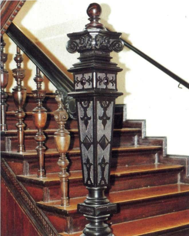
Abb. 94 Hegelstraße 33 Vierkantiger, konischer Antrittsposten mit Beschlagwerkverzierungen und Volutenkapitel, 1888
