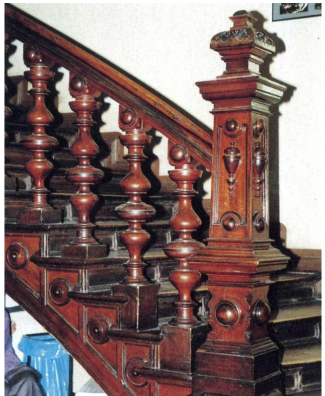
Abb. 93 Hegelstraße 2 Vierkantiger Antrittsposten an der Treppe zum Obergeschoß, dicke Traillen und verzierte Treppengewänge, 1880 bis 1882
