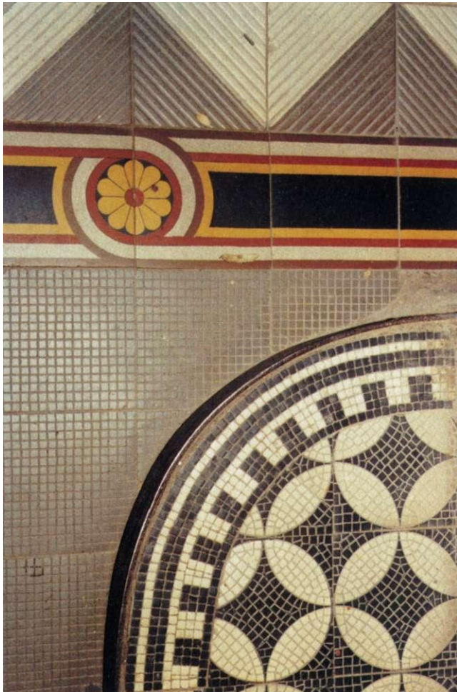
Abb. 115 Hegelstraße 2 Hier sind verschiedene Fliesensorten miteinander kombiniert, einfarbige mit Netzmuster für die Durchfahrt, Fliesen mit Mosaikstruktur für den Gehsteig und zweifarbig, geriefte Fliesen mit einer farbigen Borde für den Eingangsbereich, 1880 bis 1882
