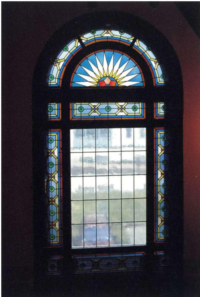
Abb. 108 Hegelstraße 33 Treppenhausfenster, große Innenscheibe nicht erhalten, Rahmen- und Bogenfenster teilweise rekonstruiert, 1888
