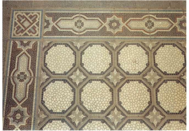
Abb. 114 Hegelstraße 18 Der Fliesenfußboden mit mosaikartiger Struktur setzt sich aus achteckigen Fliesen und kleinen Quadraten zusammen, ca. 1887
