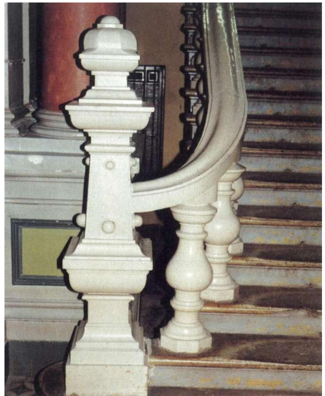
Abb. 92 Hegelstraße 2 Massiver Antrittsposten im freitreppenartigen Aufgang vom Souterrain zum Erdgeschoß, 1880 bis 1882
