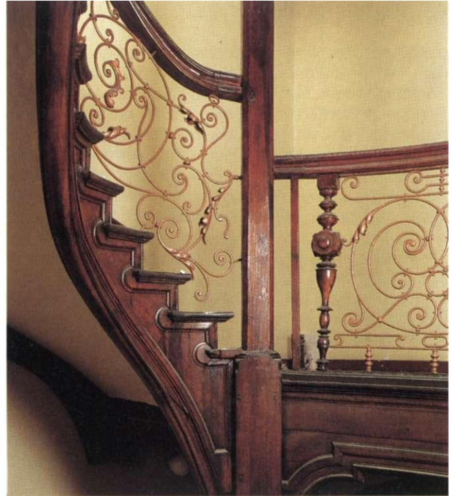
Abb. 86 Bürgelstraße 2 Handlauf und hölzerne Zwischenpfosten rahmen schmiedeeiserne Füllungen aus gebogenen Rundstäben und Blattwerk, um 1890
