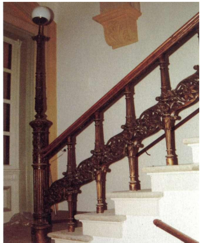
Abb. 97 Hegelstraße 1 Gußeisener Zwischenposten mit Beleuchtung, 1878
