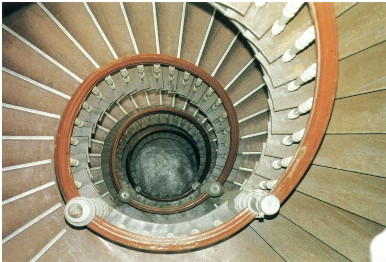
Abb. 78 Hegelstraße 35 Treppenhaus mit Wendeltreppe und integrierten Ruhepodesten, 1888
