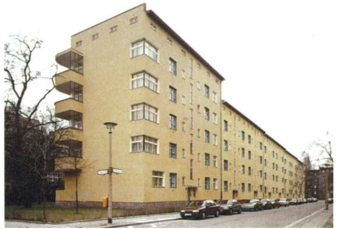
Abb. 27: Wohnstadt "Carl Legien", Berlin-Prenzlauer Berg Trachtenbrodtstraße, B. Taut, 1928/30 Straßenansicht, Zustand 1994 Foto: W. Brenne
