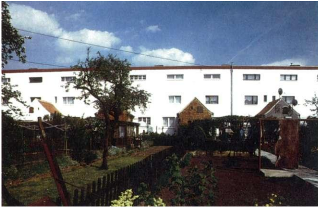
Abb. 19: Gartenstadt-Kolonie Reform, Magdeburg Lilienweg, B. Taut 1929/30 Gartenfassade, Zustand 1994, ARGE Reform - Brenne/Th. Krayl Foto: W. Brenne
