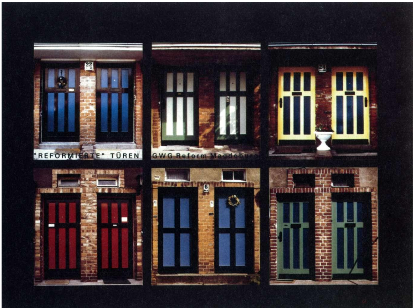
Abb. 18: Gartenstadt-Kolonie Reform, Magdeburg Hauseingangstüren, B. Taut, 1913-33 wiederhergestellt 1995, ARGE Reform - W. Brenne/Th. Krayl mit V. Beil Foto: W. Brenne
