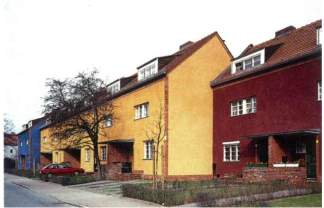
Abb. 20: Hufeisensiedlung Britz, Berlin-Neukölln Paster-Behrens-Straße 1-3, B. Taut 1926/27 Straßenansicht, Zustand 1989 Foto: Archiv Architektur- werkstatt Pitz/Brenne
