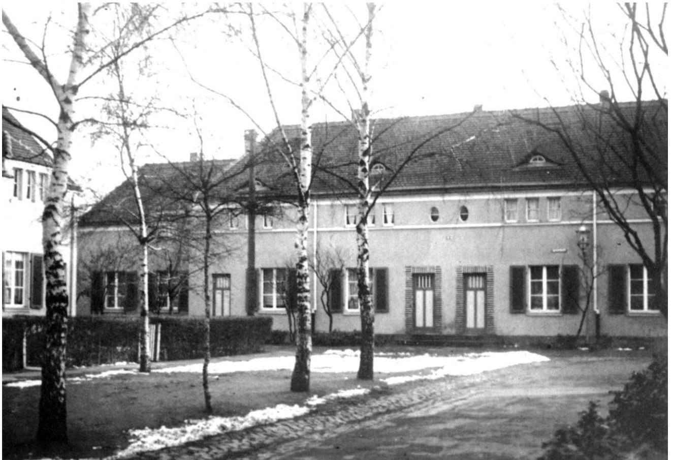
Abb. 5: Maienhof, Heckenweg 1913/14, Architekt: Bruno Taut
