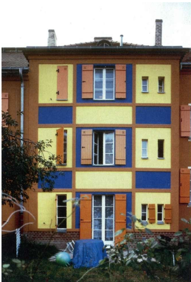
Abb. 13: Gartenstadt Falkenberg, Berlin-Treptow Gartenstadtweg 31, B. Taut, 1913/14 Gartenfassade, Zustand 1995 Foto: W. Brenne
