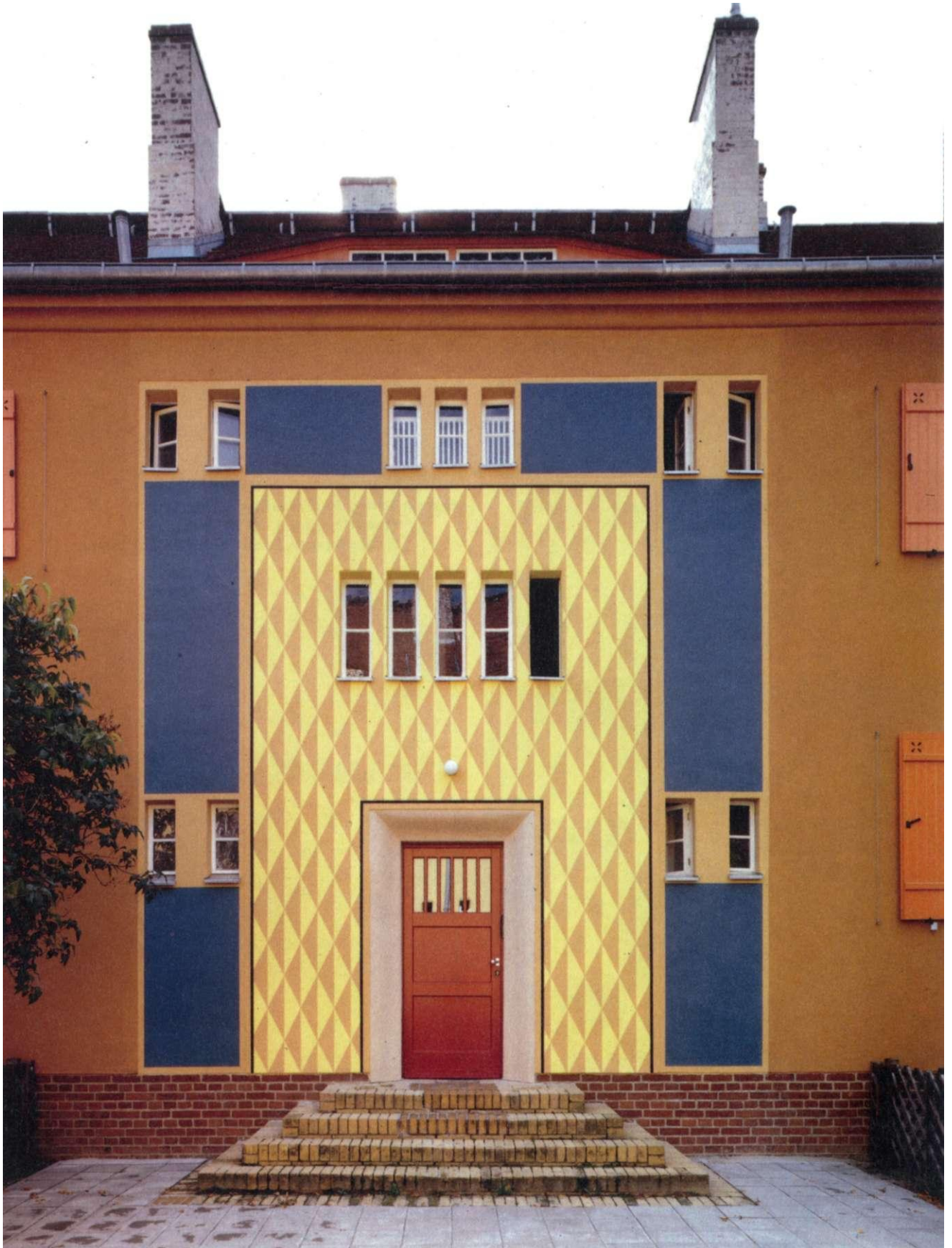
Abb. 12: Gartenstadt Falkenberg, Berlin-Treptow Gartenstadtweg 29, B. Taut, 1913/14 Hauseingang, Zustand 1994 Foto: H. Gackstatter
