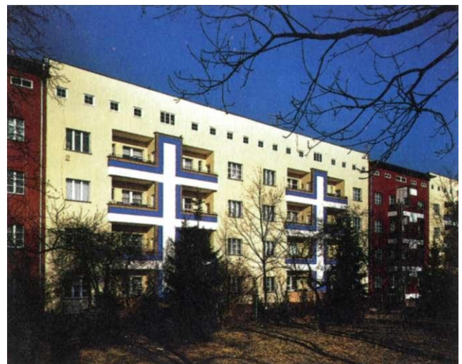
Abb. 24: Wohnbebauung Trierer Straße, Berlin-Weißensee Trierer Straße 8-18, B. Taut, 1925/26 Gartenansicht, Zustand 1994 Foto: H. Gackstatter
