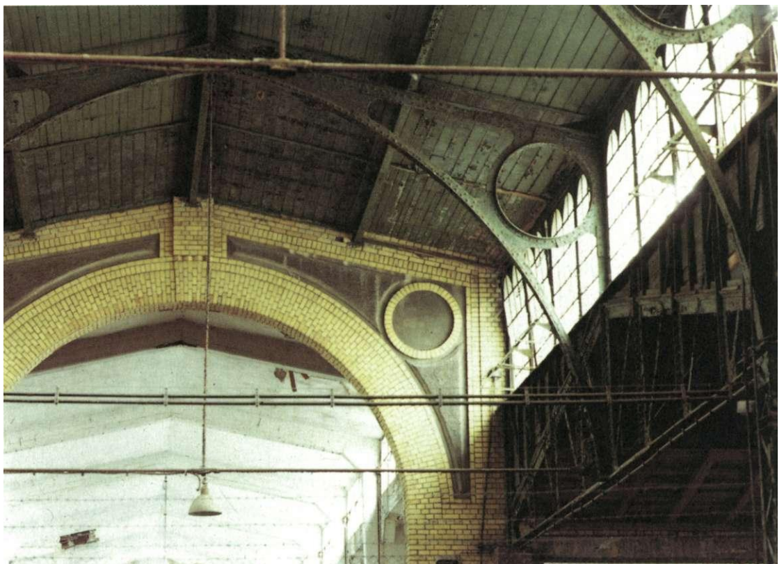
Detail der Deckenkonstruktion der Schweinemarkthalle, im Hintergrund ist der Anbau aus den 20er Jahren zu sehen.
