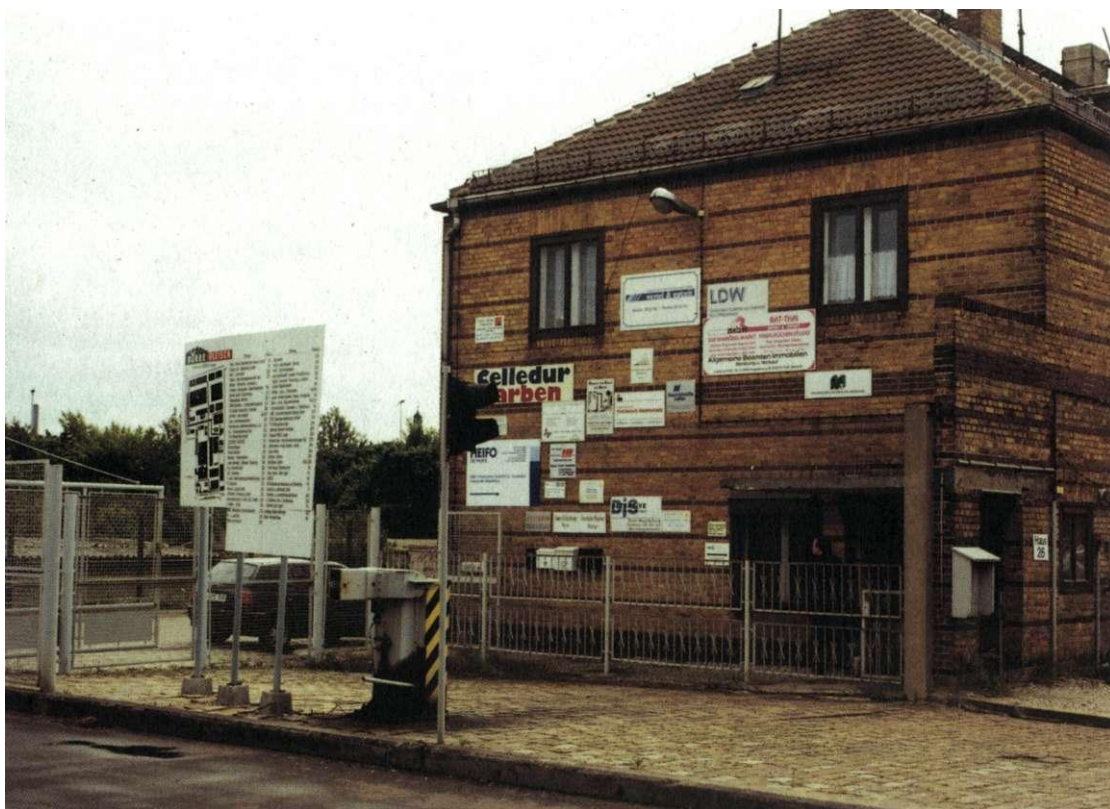
Eingang Schlachthofstraße mit ehemaligem Beamtenwohnhaus.
