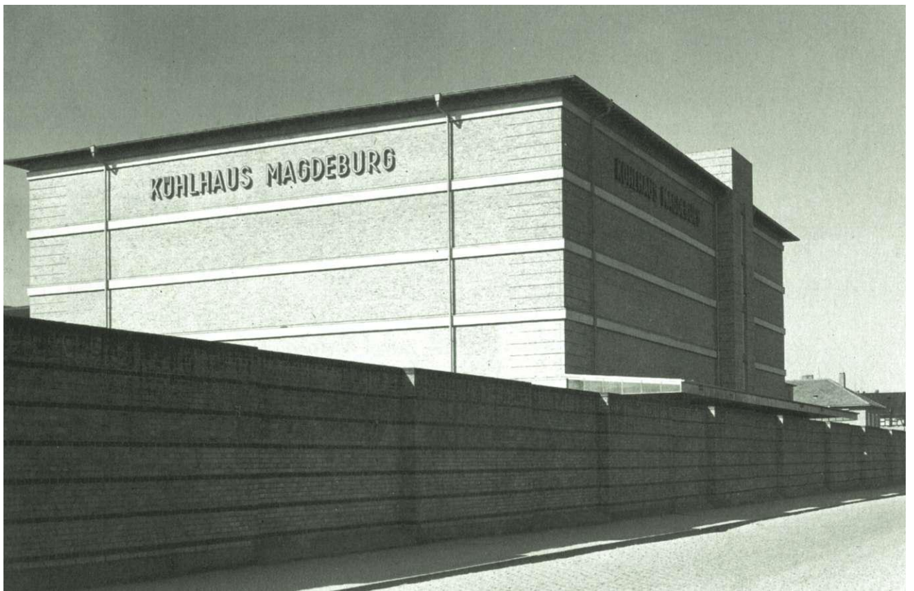
Kühlhaus nach der Fertigstellung, von der Schlachthofstraße.
