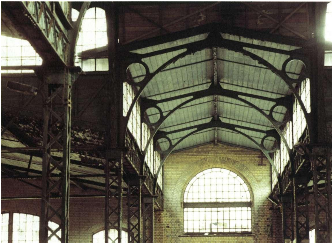
Detail der Deckenkonstruktion über dem Südtor der Schweinemarkthalle.
