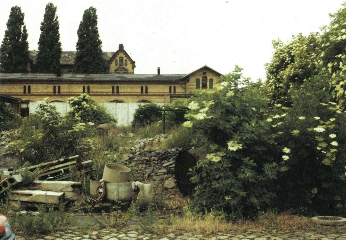
Hinter dem ehemaligen Pferdestall, Blick zum Verwaltungsgebäude.
