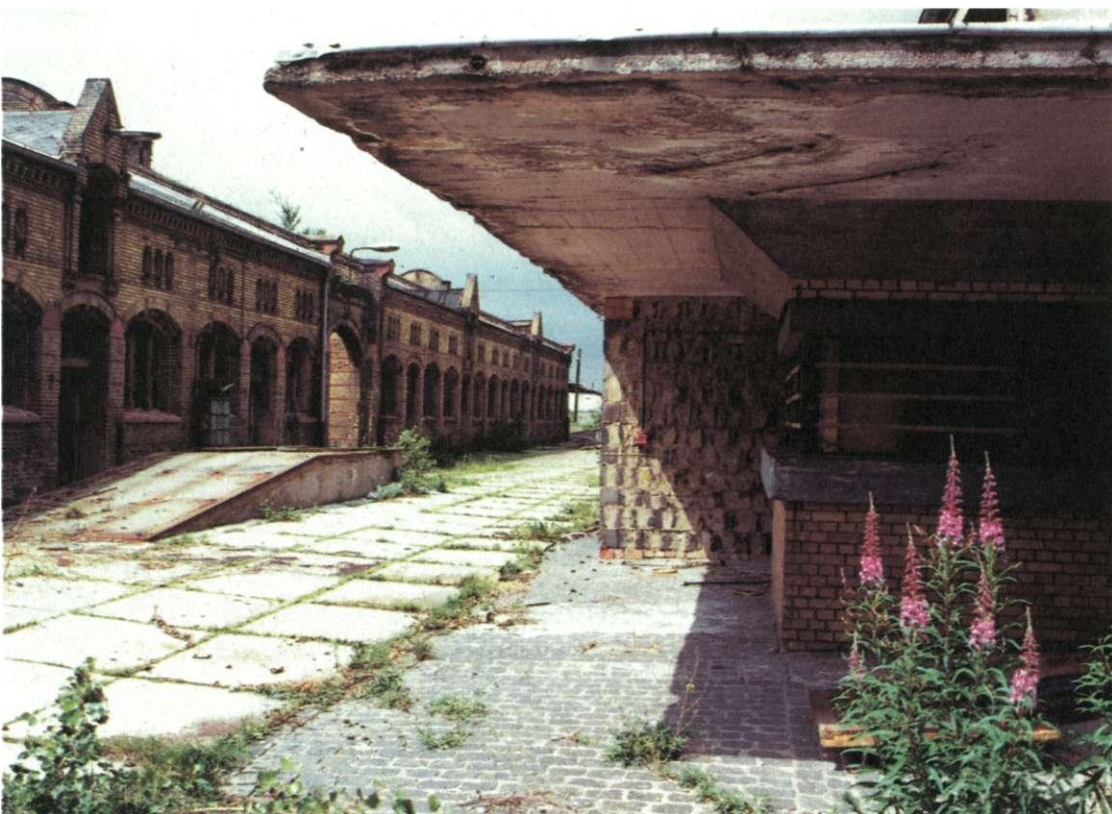
Eine Besonderheit an der Rindermarkthalle ist das 4m tiefe Kragdach im Südostteil.
