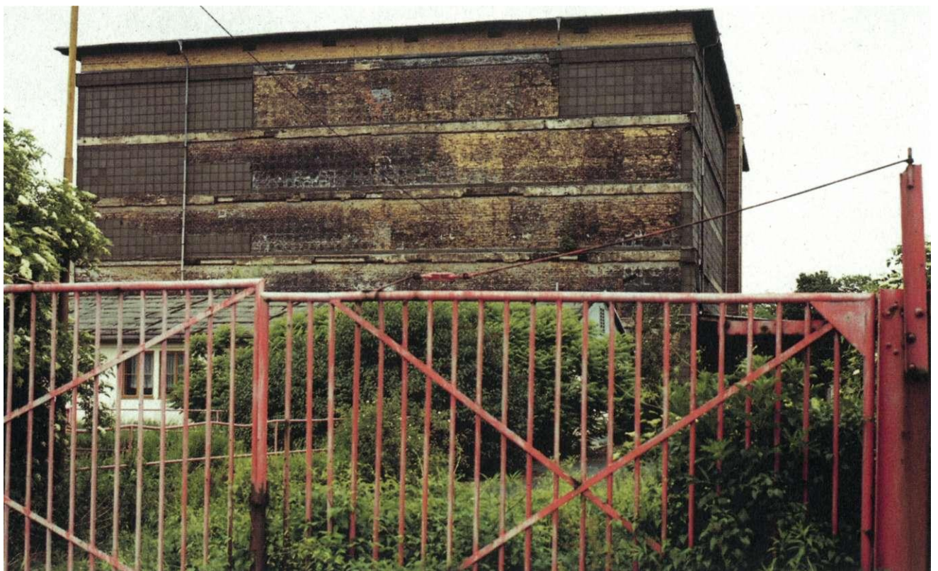
Kühlhaus 1994 von der Schlachthofstraße.
