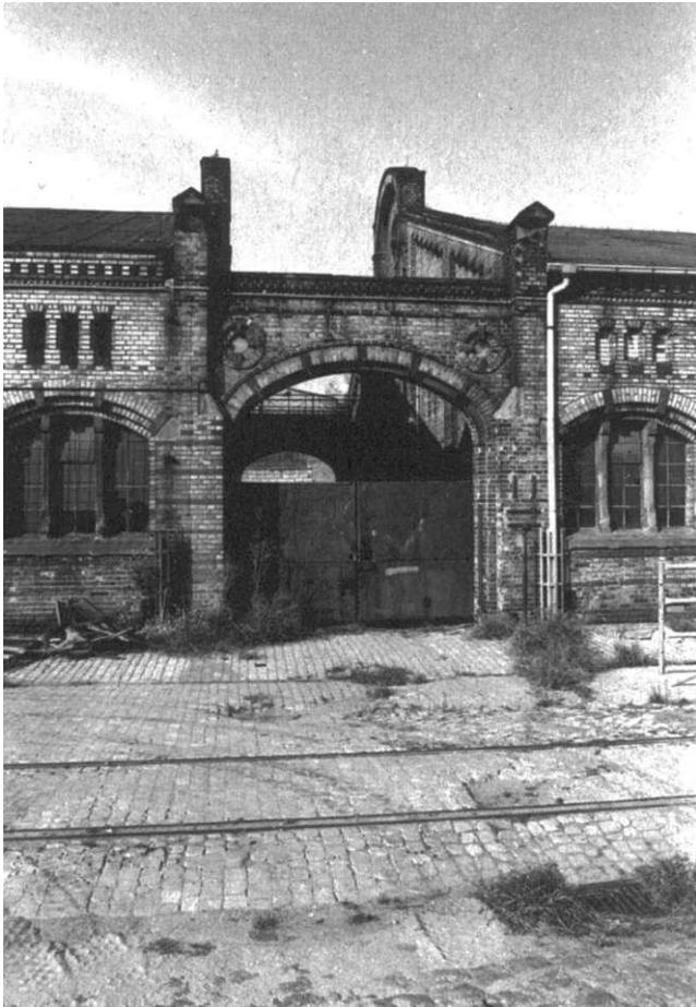
Tordurchfahrt bei den Rinderställen.
