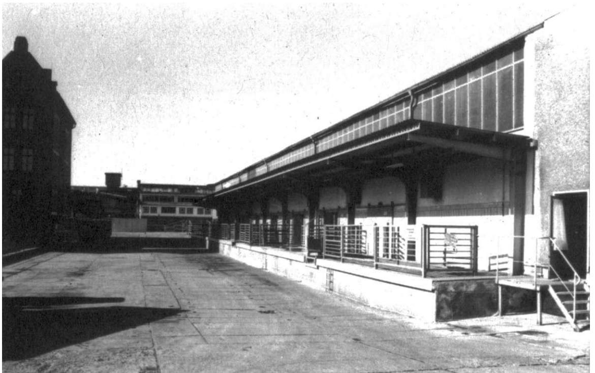
Neue Schweine-Schlachthalle, im Hintergrund der südliche Teil der Rinder-Schlachthalle.
