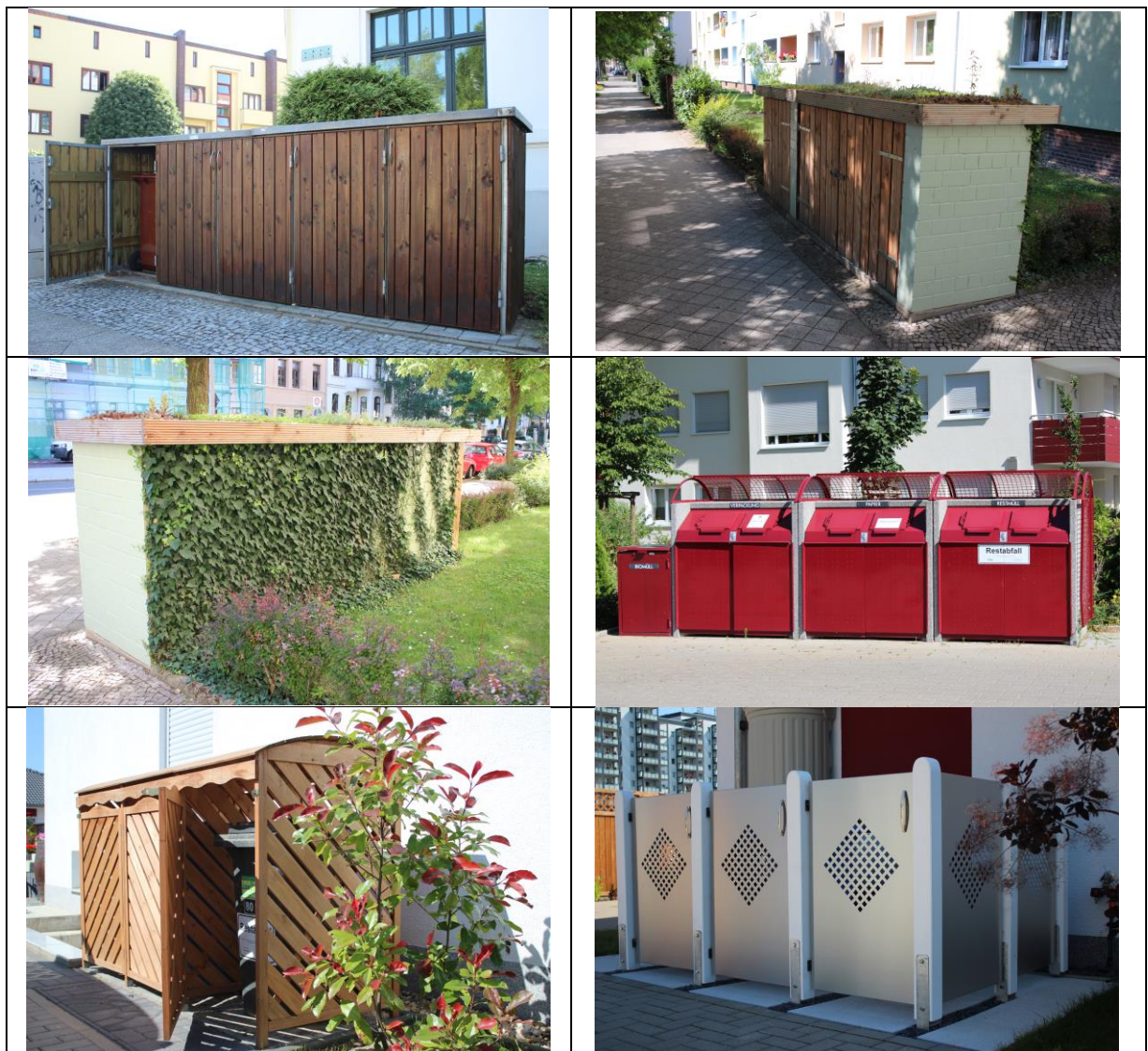
Behälterschränke und Einhausung
