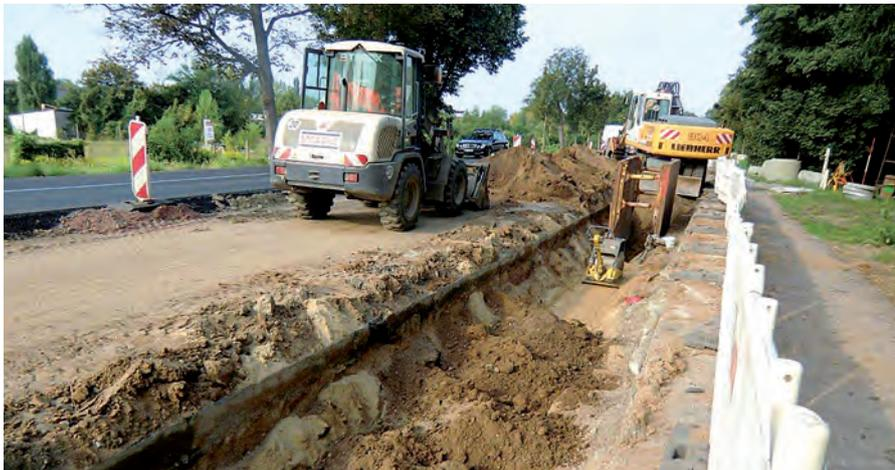
Die B1/Berliner Chaussee liegt mit ihrem Böschungsfuß des Straßendamms teilweise im Einflussgebiet extremer Hochwässer der Elbe, mit einer erheblichen Auswirkung auf den Grundwasserstand in diesem Areal. Aus diesem Grund musste für die B1 im Bereich der Berliner Chaussee, die bisher keine Entwässerungseinrichtung besaß, eine leistungsfähige Entwässerungsanlage konzipiert und eingebaut werden.
