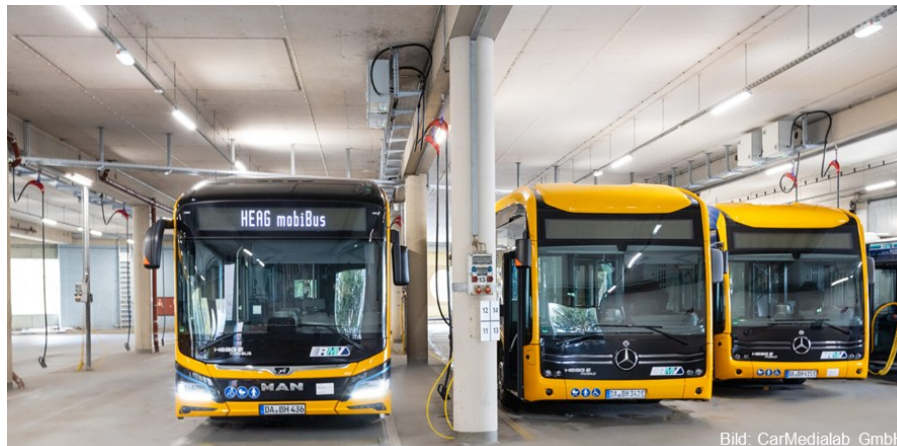
Abb. 62: Praxisbeispiel Depotladung mit Steckerzuführung von oben
