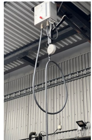
Abb. 61: CCS Anschlussbox mit Seilzug-Abrollsystem
