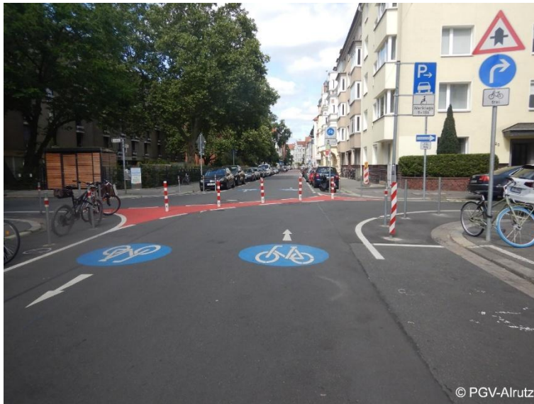
Abb. 2-7: Diagonalsperre (Hannover, Edenstraße)
