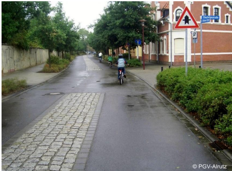
Abb. 2-4: Mittlerer Pflasterstreifen in Fahrradstraße (Senftenberg)
