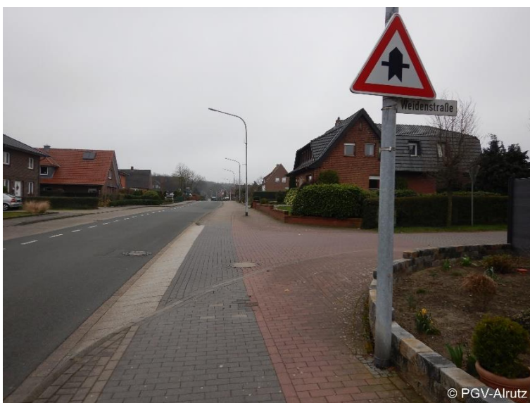
Abb. 4-20: Rad- und Gehwegüberfahrt mit Rampenstein
