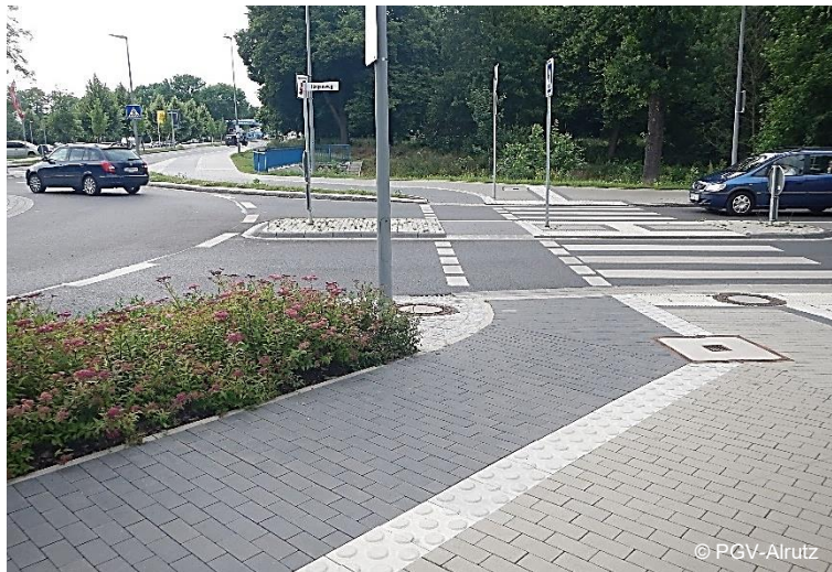
Abb. 4-24: Kleiner Kreisverkehr innerorts mit bevorrechtigter Radwegführung neben Fußgängerüberweg
