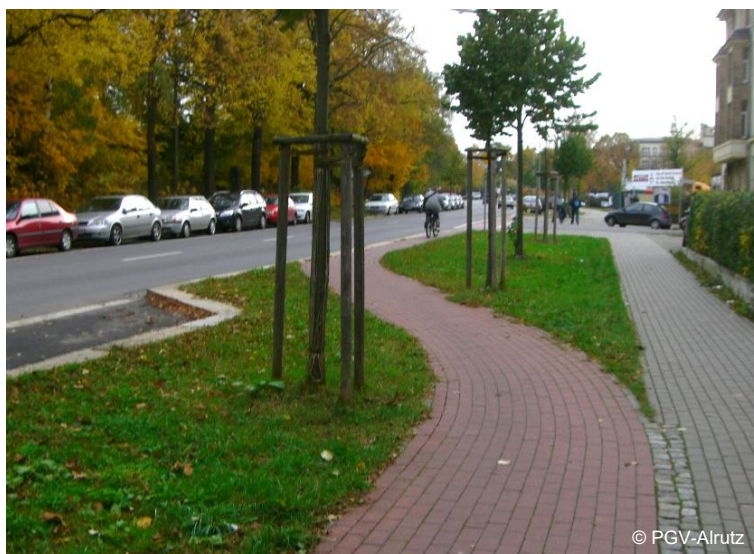
Abb. 4-21: Heranführen eines Radwegs an die Vorfahrtstraße, um die Sichtbeziehungen zwischen rechtsabbiegenden Kfz und Radverkehr zu verbessern
