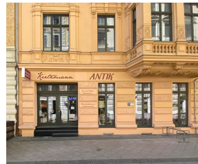
Die Werbung entspricht weitestgehend dem Gestaltungskonzept: Empfohlen wird der Verzicht auf Flachwerbung (Beschriftungen) auf Fassaden.
