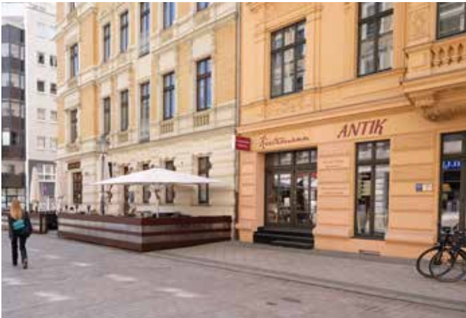
Abb.28: Durch Einhausung entstandene Ecksituationen als potenzielle „Müllplätze“
