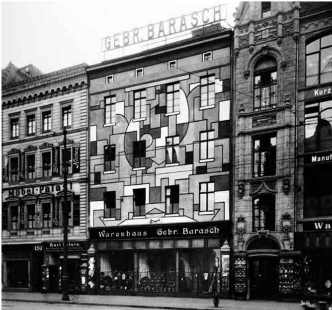
Abb.13: Bunte Fassade am Breiten Weg 149 (Quelle: https://www.magdeburger-moderne.de )
