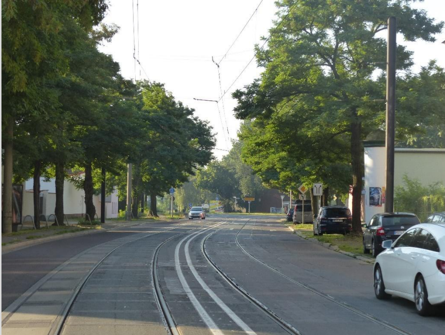
Foto 15 – Straßenabschnitt in Alt Westerhüsen, © LA Westhus
