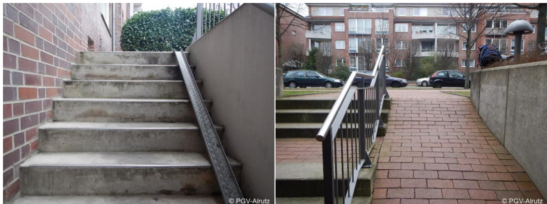
Abb. 1-1: Treppen mit Schieberampe (links) und mit separater Rampe (rechts)
