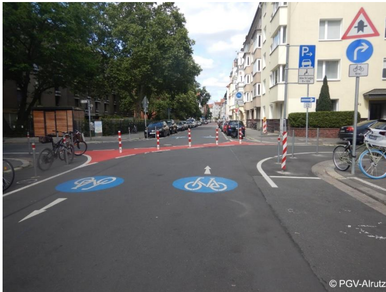
Abb. 2-7: Diagonalsperre (Hannover, Edenstraße)
