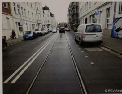
K 1227 Genthiner Straße Mischverkehr bei DTV ca. 14.000 Kfz/Tag Sturzgefahr durch Schienen
