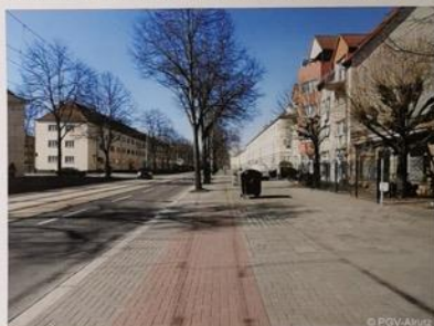
L49 Große Diesdorfer Straße DTV ca. 14.000 Kfz/Tag Radweg (1,10m Breite) zu schmal (ohne Ben.pfl.) Belagsqualität eingeschränkt
