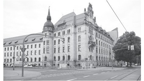
Landgericht Magdeburg Foto / Architekturbüro ars domus Dresden
