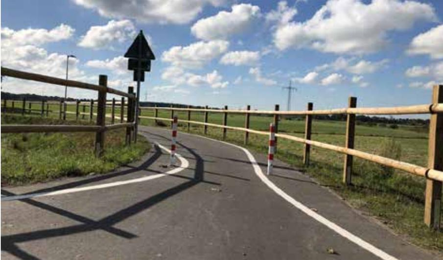
Realisiert wurde der Ausbau des 4,5 km langen Radwegs zwischen dem Leegmeedlandsweg und der Esklumer Straße. Der Radweg ist mit Asphalt auf 2,5 bis 3 m verbreitert worden. Auf der Strecke wurde außerdem eine Beleuchtung installiert und eine neue Geh- und Radwegbrücke am Esklumer Sieltief gebaut. Die Gesamtkosten lagen bei ca. 4 Mio. Euro.
