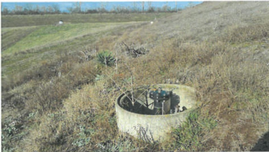
**Bild 4:** Gasbrunnen vor der Verlängerung (Südböschung)
