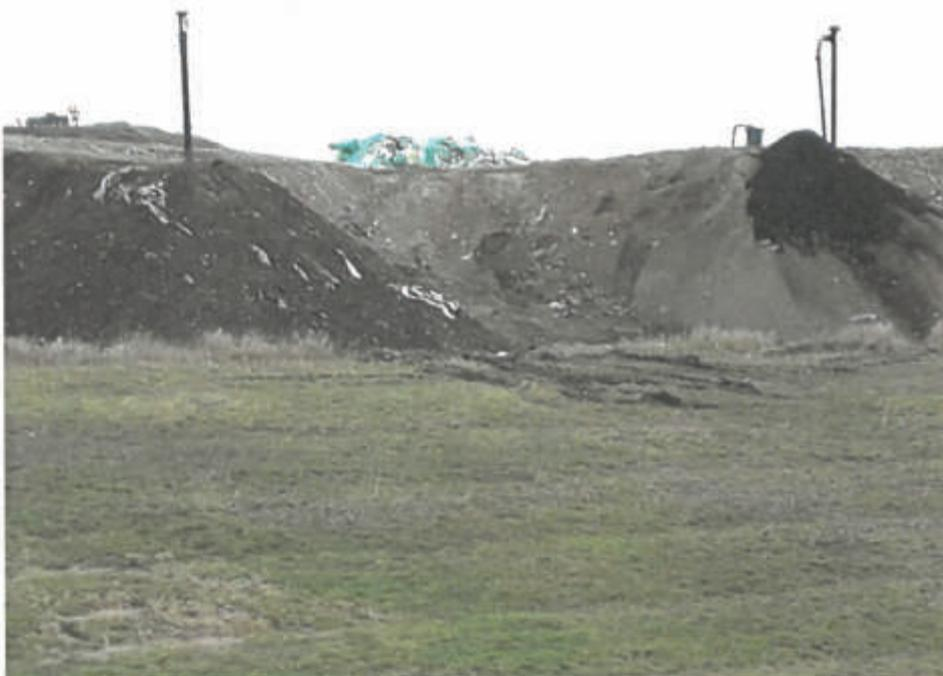
**Bild 5:** Gasbrunnen/Pegel nach der Verlängerung einschl. teilweiser Böschungsverfüllung
