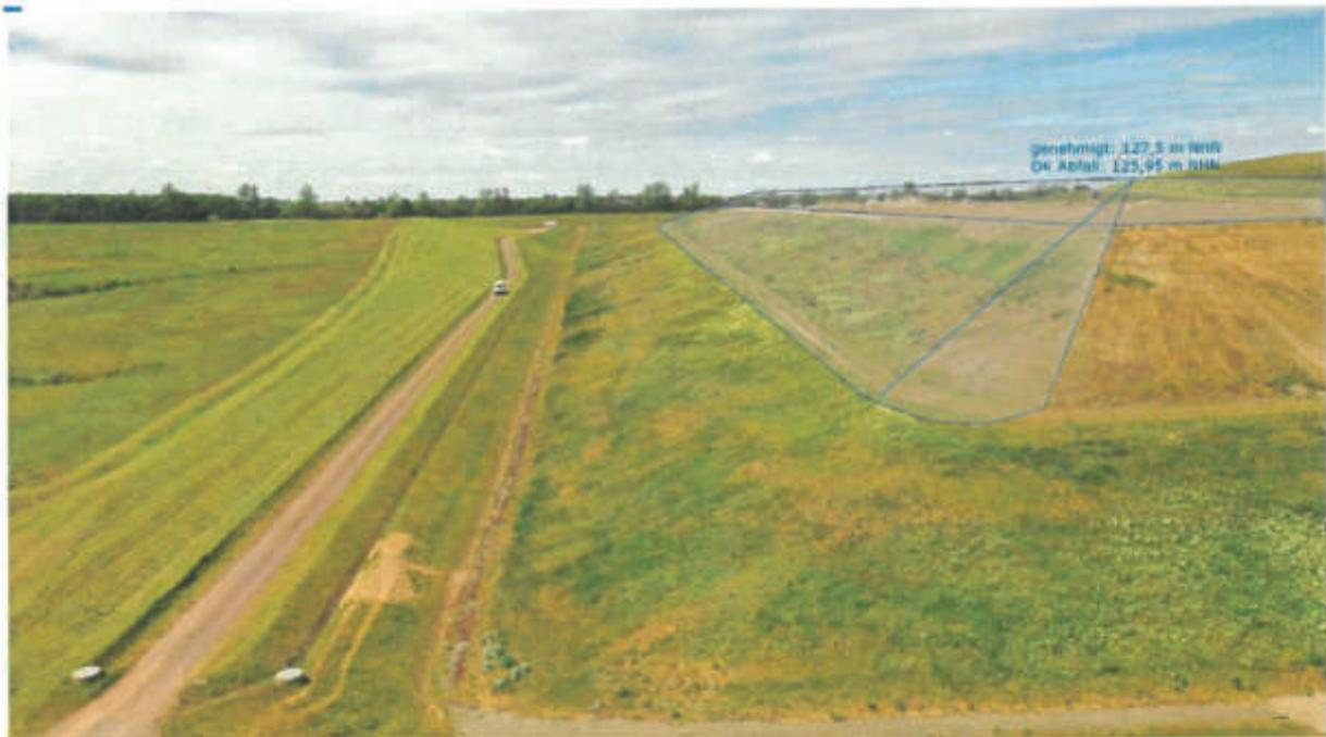
**Bild 1:** Kapazitätsoptimierung durch Überschüttung der Südböschung
