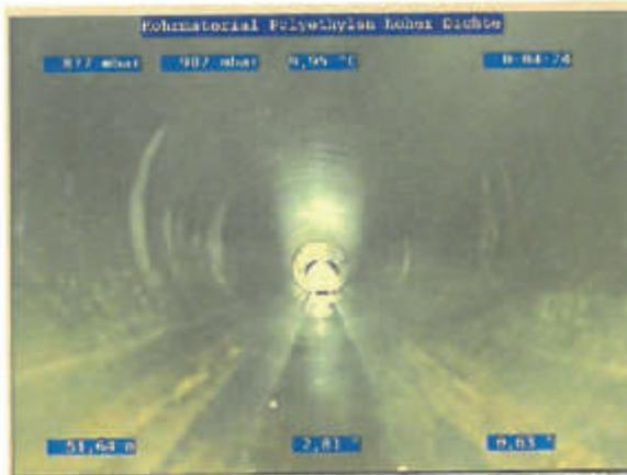
**Bild 19:** Foto Rohrleitung Sickerwassersammelrohr Haltung S5-S4
