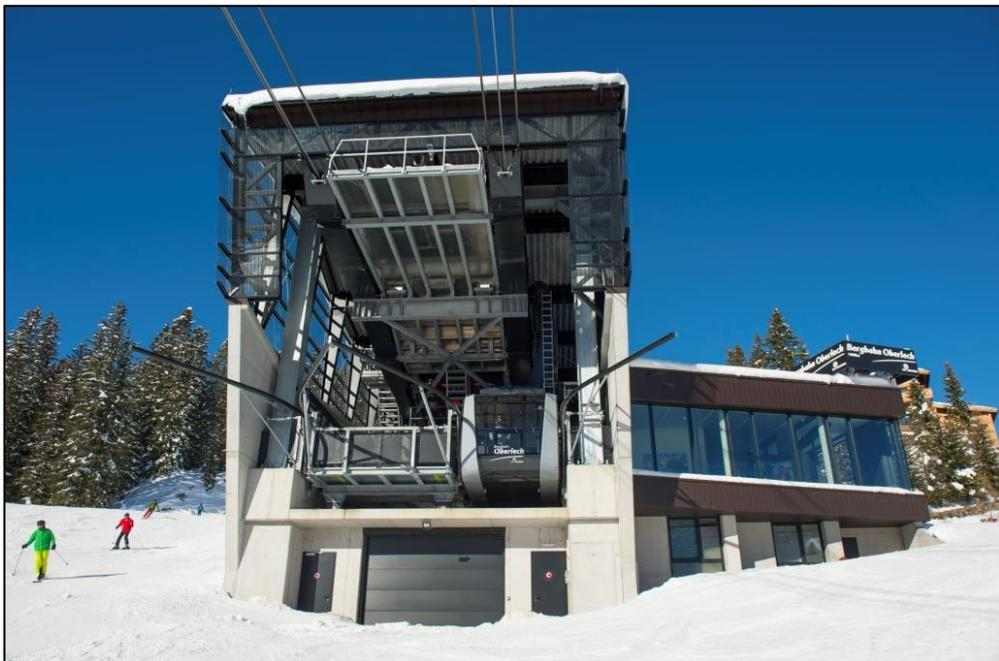
Abbildung 11: Pendelbahnstation mit Verschiebebahnsteig, Quelle: IB Schweiger
