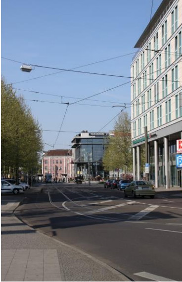
Abbildung 31: Große verglaste Fassaden sind problematisch für sommerliche Wärmeeinträge in Gebäude, helle Fassadenfarben wirken positiv auf die klimatischen Verhältnisse in Inneren (© Matthias Haberland/PIXELIO)
