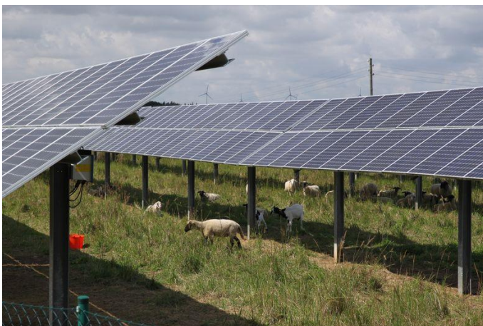
Abbildung 62: Solarpark auf Kaltluftproduktionsfläche, Quelle: Jakob Maercker
