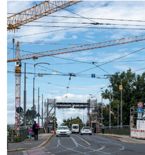
Anna-Ebert-Brücke – derzeitige Verkehrssituation
