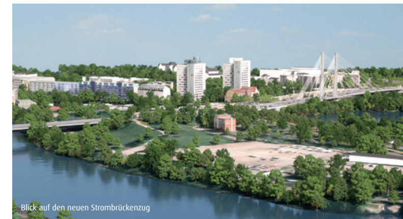
Blick auf den neuen Strombrückenzug
