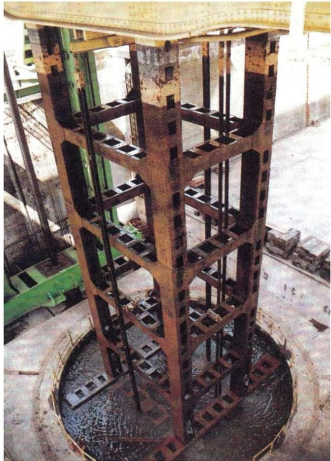
Abb. 32: Schiffshebewerk Rothensee: Trägerbrücken verbinden den Trog mit den Schwimmern.
