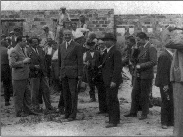
Besuch von städtischen Mitarbeitern bei den Selbst Helfern. Offenbar wurde hier das Ende der Beton- und Maurerarbeiten vor Errichtung des Fachwerk-Obergeschosses gemeinsam begossen.
