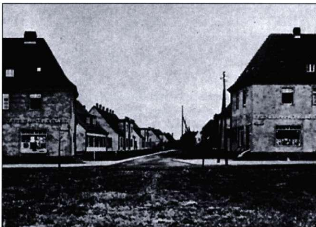
Die Häuser an der Beyendorfer Straße mit Bäckerei und Verkaufsstelle des Eisenbahn-Konsum-Vereins am hervorgehobenen Siedlungsmittelpunkt, 1930.
