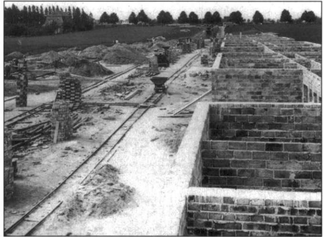
Das Baustellenfoto zeigt die Anbindung an die Ballenstedter Straße. Die östliche Häuserreihe entstand zuerst, die Bautechnologie war auf rein handwerklicher Erstellung der Häuser ausgerichtet. (Quelle: Stadtarchiv Magdeburg).
